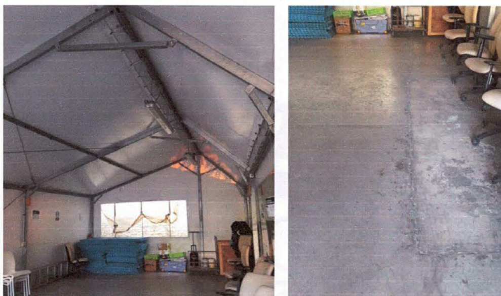
Foto carpa y radier existente.
