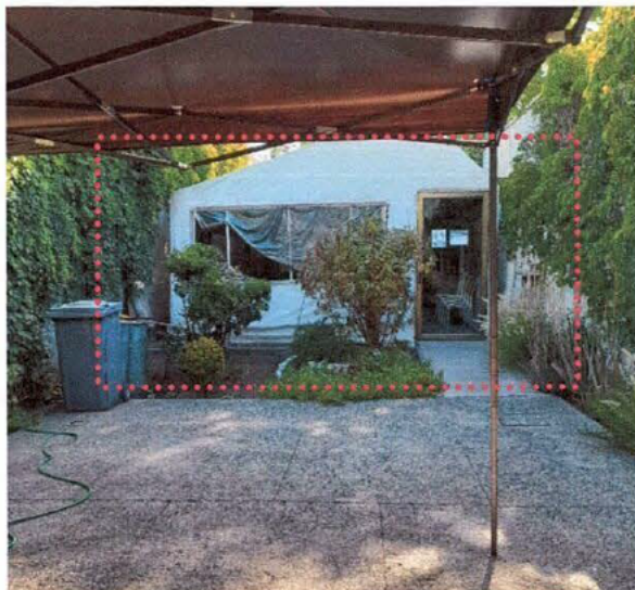
Foto patio y carpa piso 1
