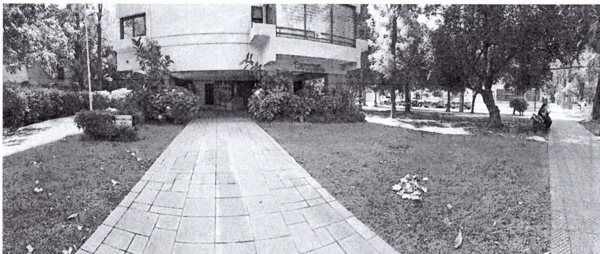
Figura 9: Imagen eje de acceso al edificio por avenida Ricardo Lyon
