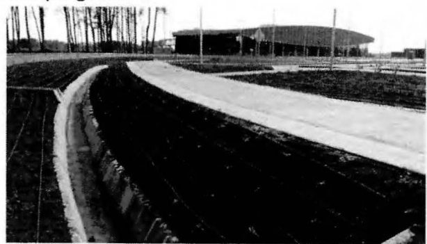
Imagen 13: Macizo con líneas de gotero instalada.
