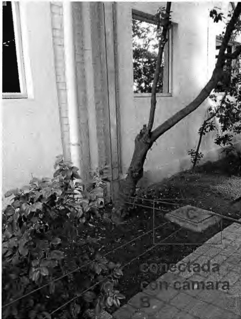
Conexión entre cámaras antes de subida.
