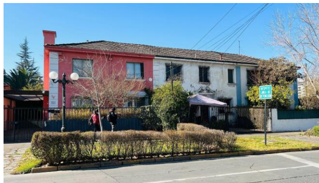
Figura 16. Conjunto de viviendas en calle Holanda en el barrio El Aguilucho, Providencia Fuente: DAU, 2022
