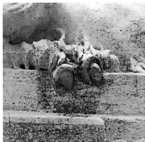
Reintegración de volumen con mortero de cemento.
