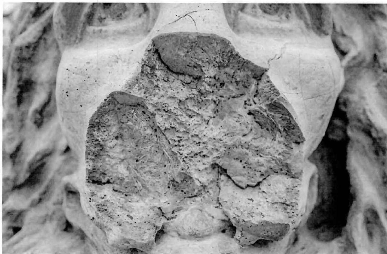
Figura 14: Fotografía situación actual León N°1 Fuente: Municipalidad de Providencia.
