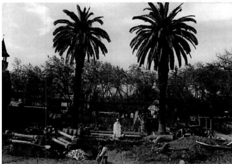
Figura 5: Fotografía exterior construcción Plaza Centenario Palacio Falabella Fuente: Municipalidad de Providencia.
