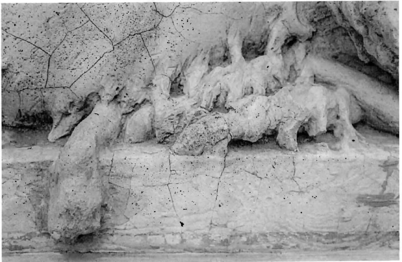
Figura 16: Fotografía situación actual León N°1 Fuente: Municipalidad de Providencia.
