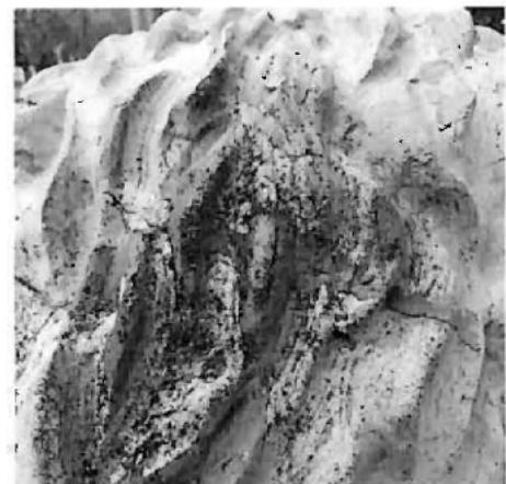
Reintegración de volumen con mortero de cemento.
