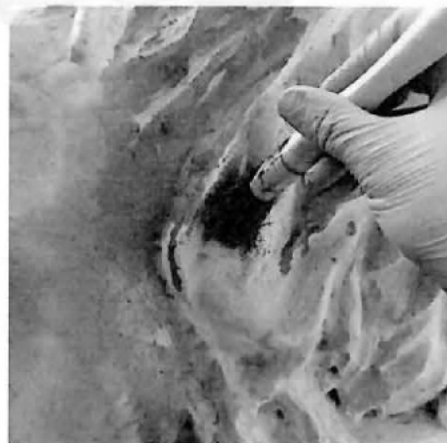
Aplicación de silicato de etilo sobre la superficie de la pieza.
