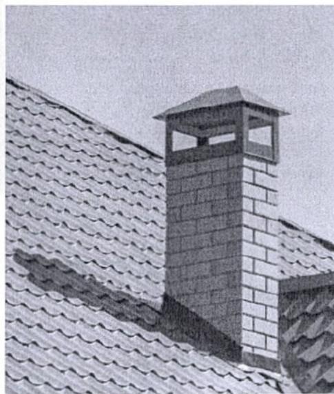
Imagen referencial de cubierta salida chimenea
