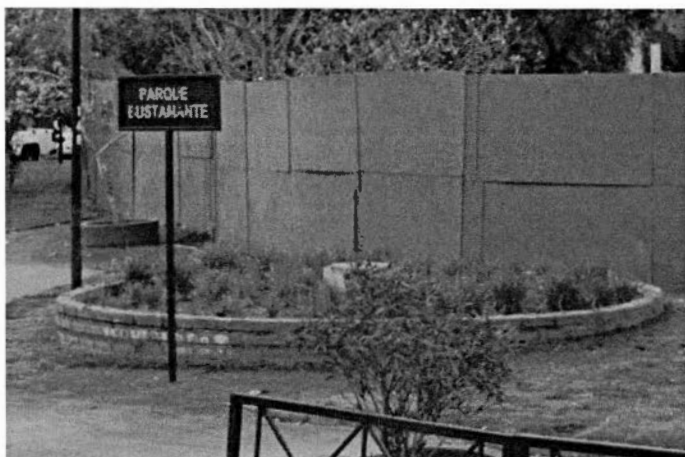
Imagen murete que se demuele
