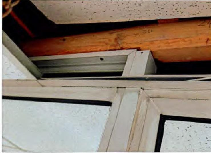
Figura 13. Unión existente tabiques a estructura de techumbre
