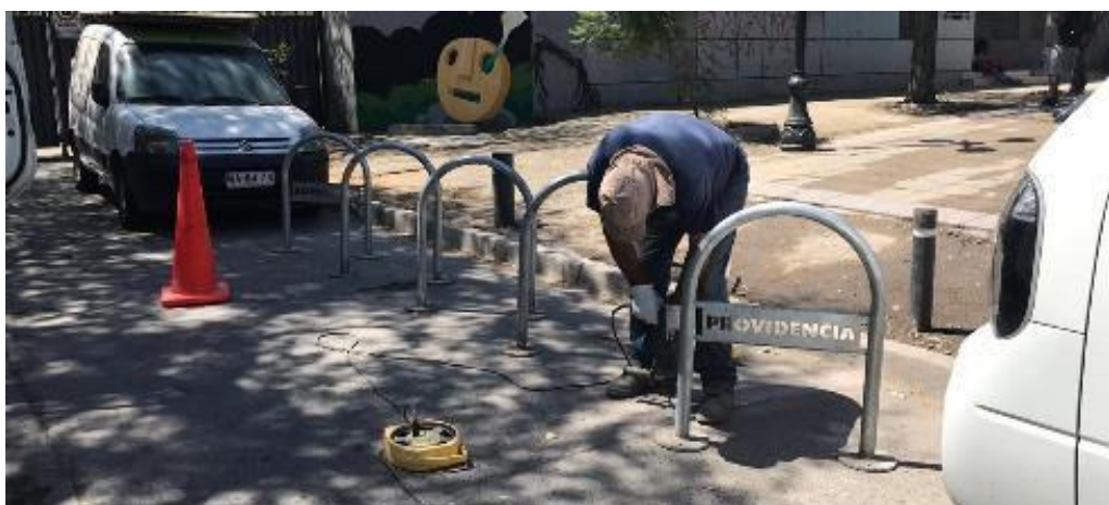
Bicicleteros municipales instalados en calzada
