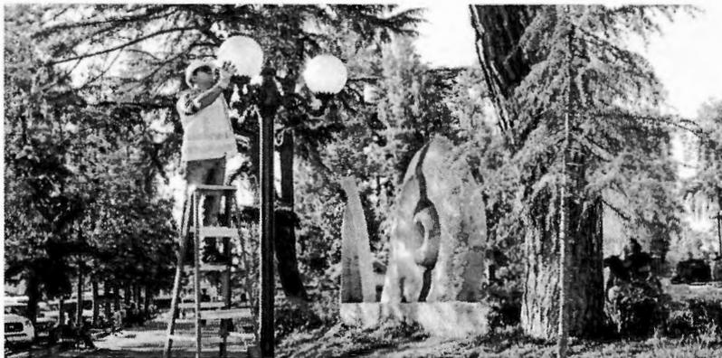
En el año 2015, en estas instalaciones fueron reemplazadas las lámparas de descarga de vapor de Mercurio y Haluro Metálico, por lámparas LED de 30W del tipo Corn Maize, según se puede ver en los listados de partidas correspondientes.
