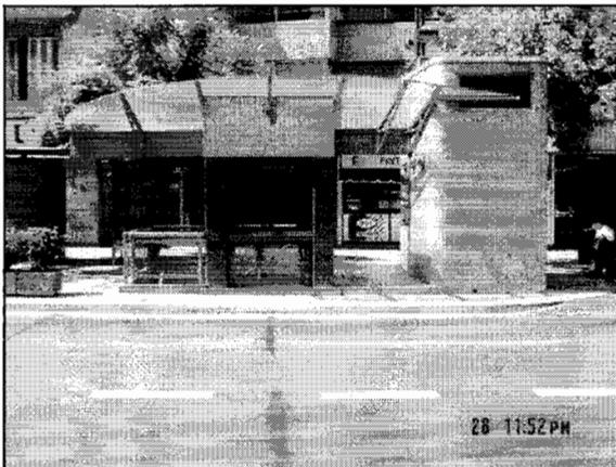
Se trata de las planchas de vidrio y estructura soportante (vigas) que conforman la techumbre de las salidas peatonales (8) se ubican a una altura promedio de 2.9 m. y deben ser atendidos por ambas caras. Cabe hacer presente que esta estructura consta de dos caras que convergen hacia el centro (eje) donde se acumularan hojas y otros elementos lo que deberán ser retirados para la perfecta evacuación de aguas lluvias.
