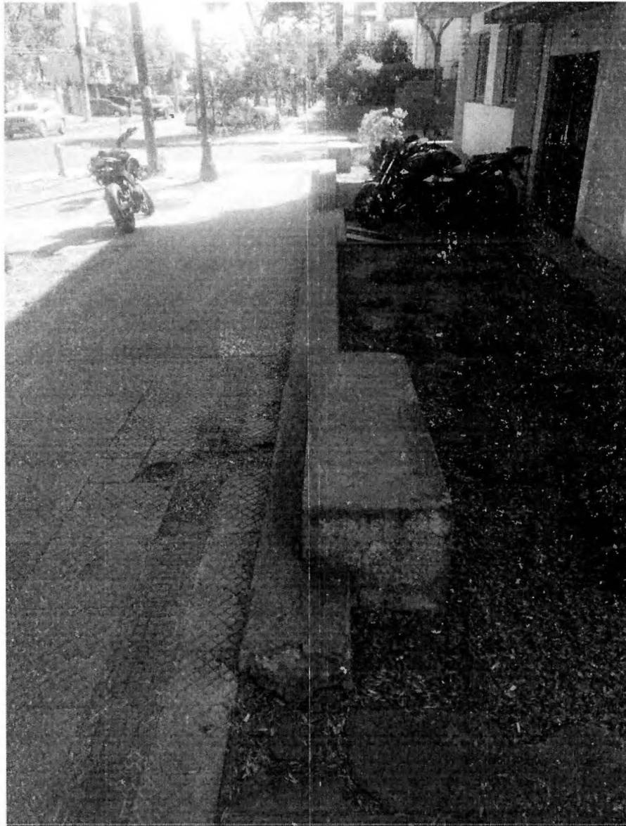
**Figura 35:** Fisura y desprendimiento de hormigón en jardineras de hormigón.
