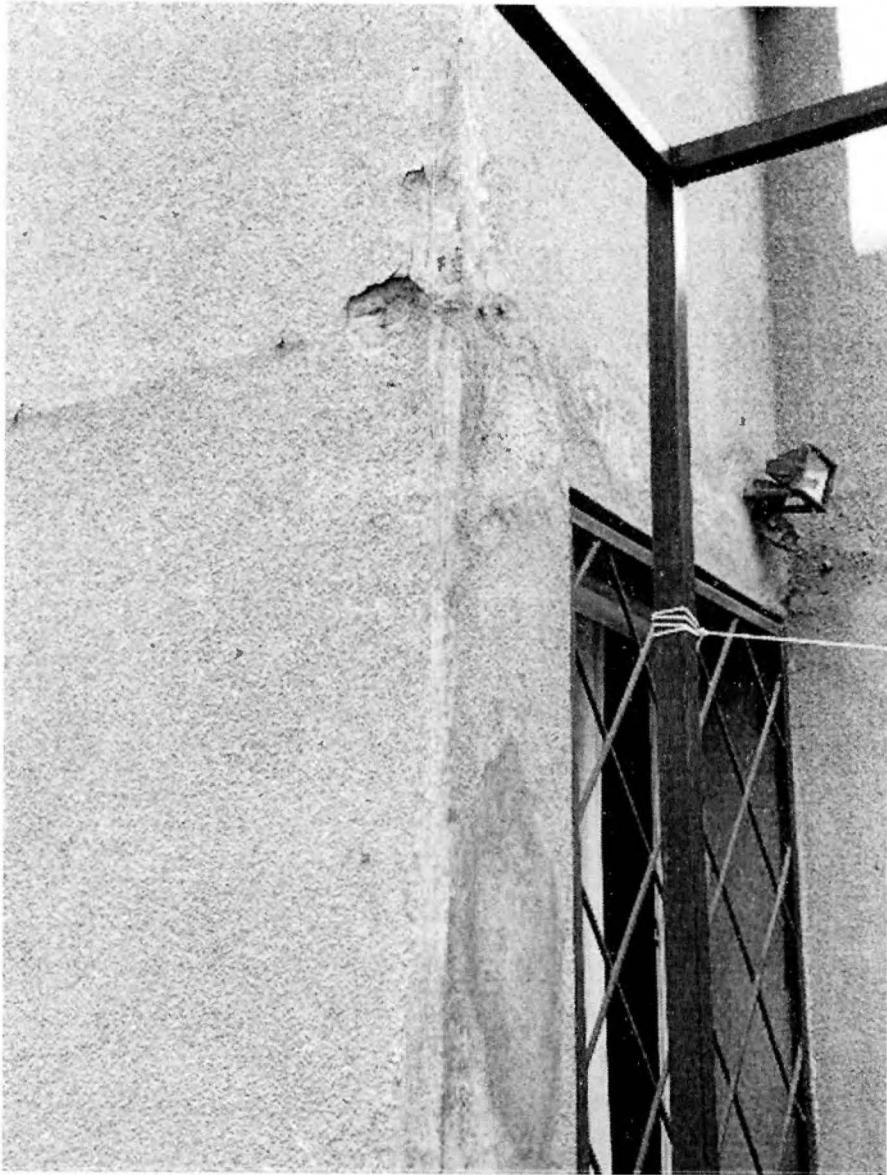
**Figura 23:** Grieta en estucos de vértice de muros fachada este con fachada norte.
