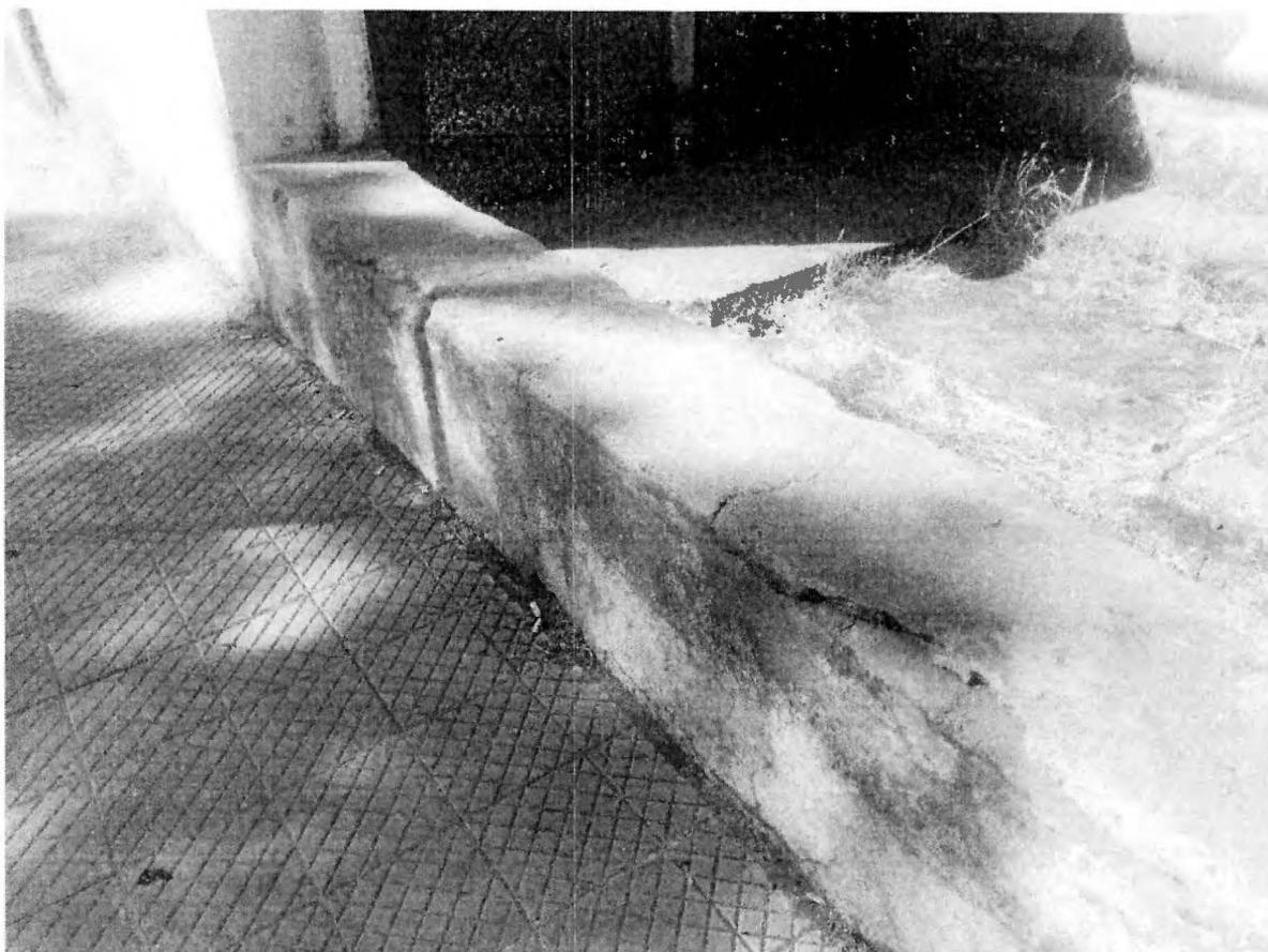
**Figura 37:** Fisura y desprendimiento de hormigón en jardineras de hormigón.
