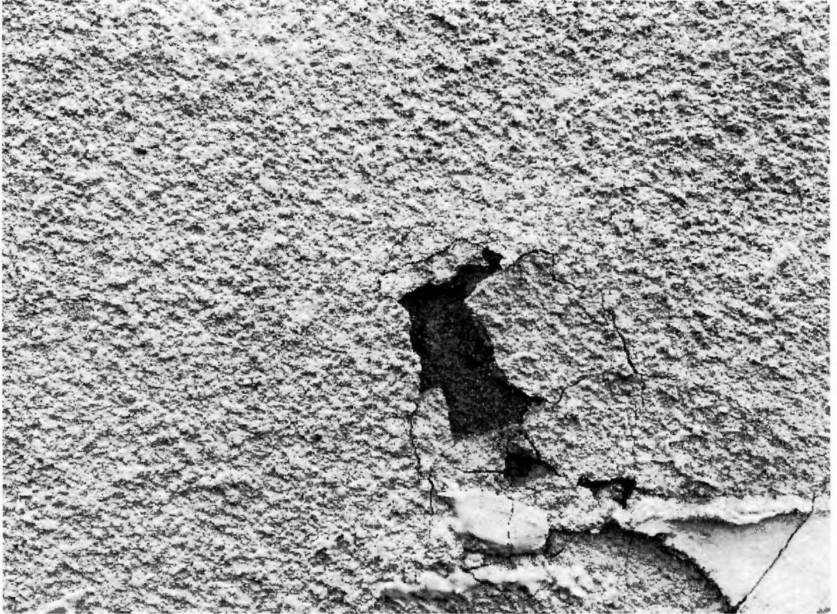
**Figura 24:** Estucos soplados en muros de fachada este.
