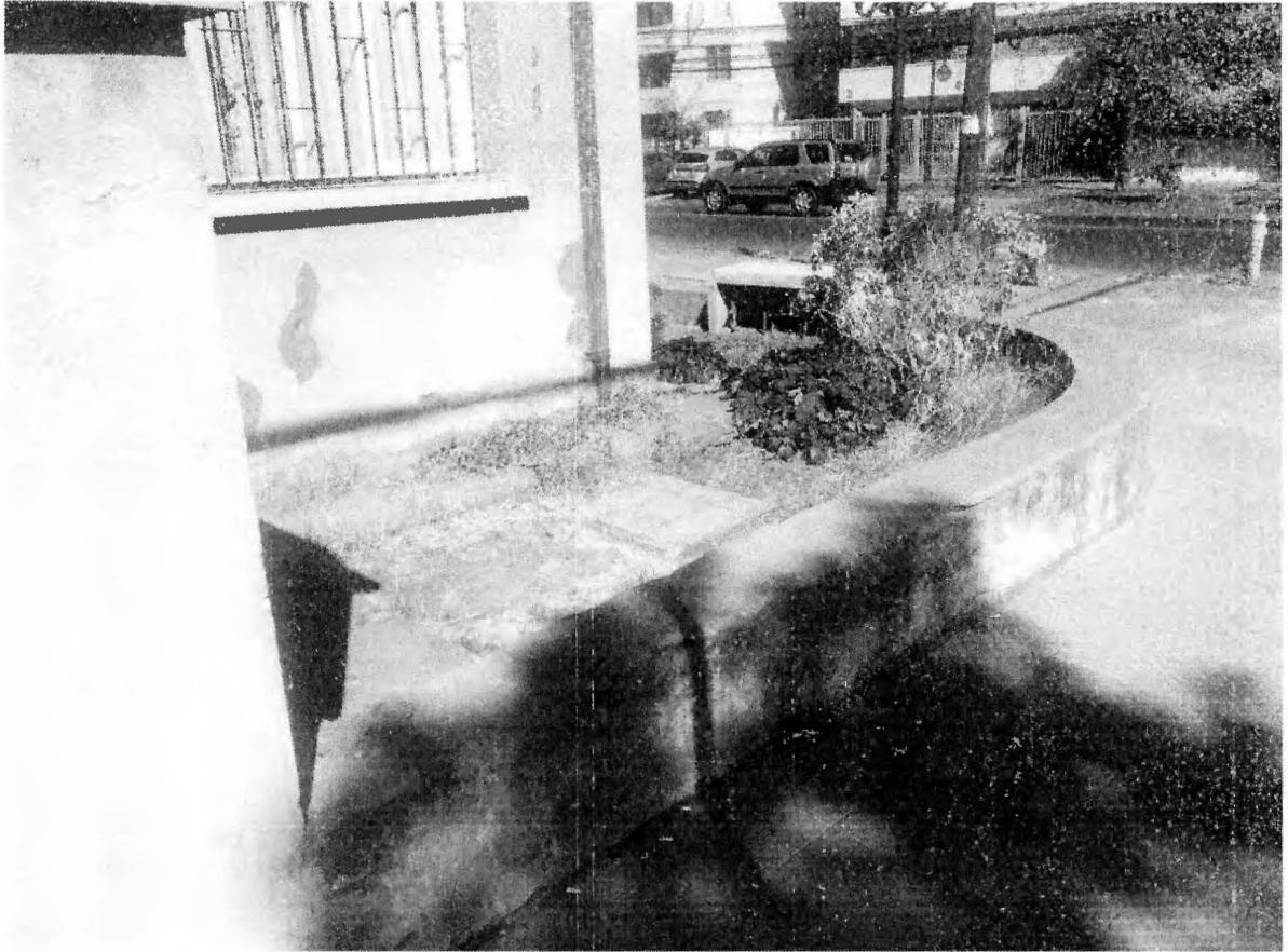
**Figura 38:** Fisura y desprendimiento de hormigón en jardineras de hormigón.
