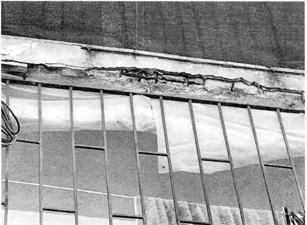
**Figura 26:** Desprendimiento de recubrimiento en losa de balcón de fachada oeste.
