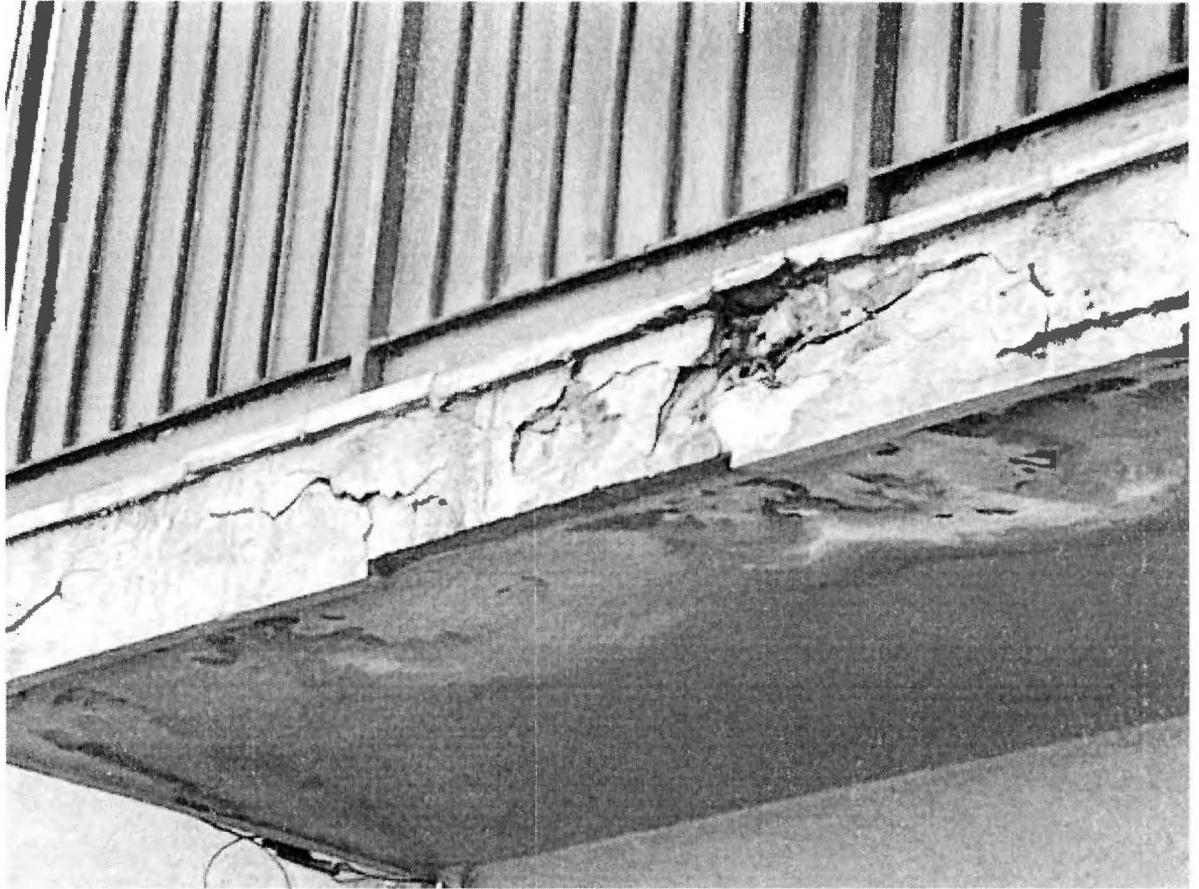
**Figura 28:** Desprendimiento de recubrimiento en losa de balcón y barandas con oxidación en fachada oeste.
