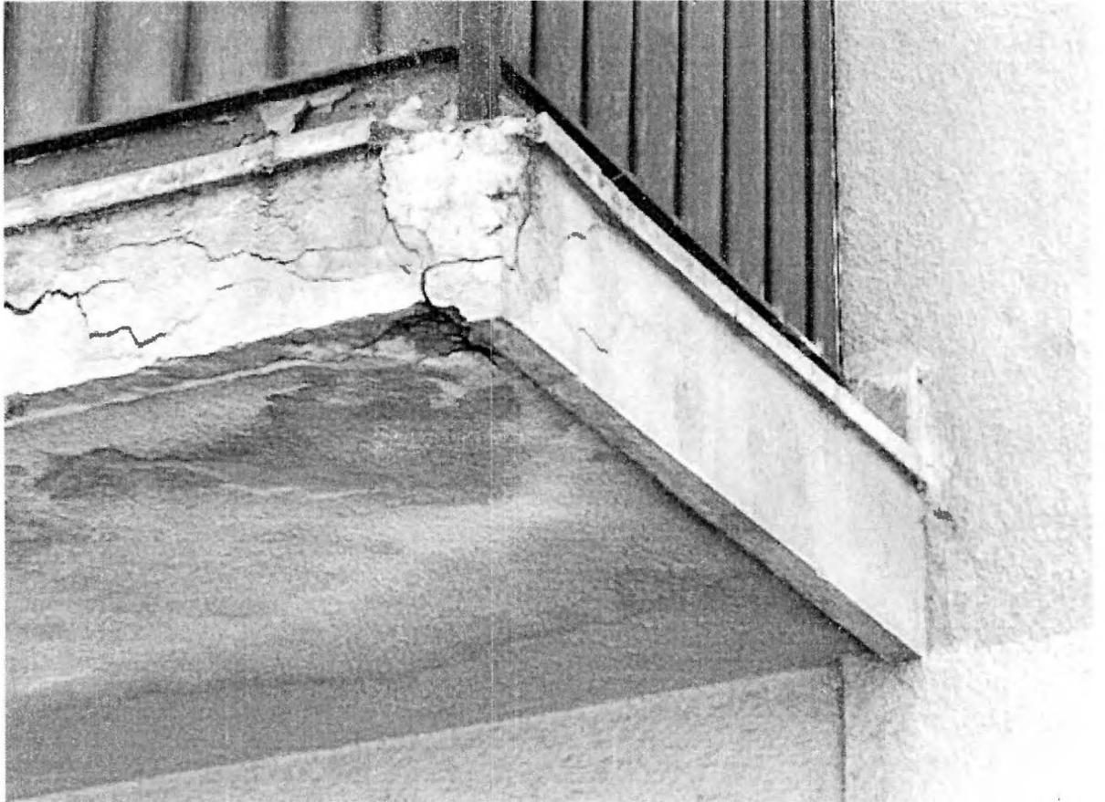
**Figura 11:** Fisuramiento típico en recubrimiento de losas de balcones de fachada sur.
