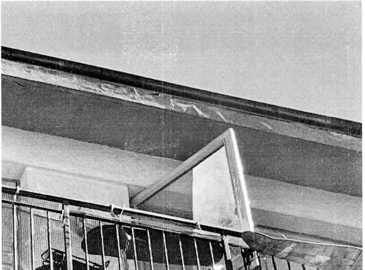
**Figura 6:** Daño típico desprendimiento de alero de techo en fachada sur.
