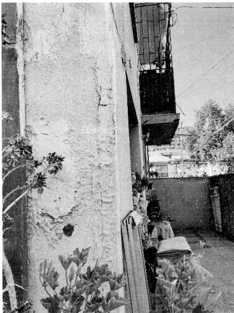
**Figura 16:** Fisuramiento de estucos en muros de fachada norte.
