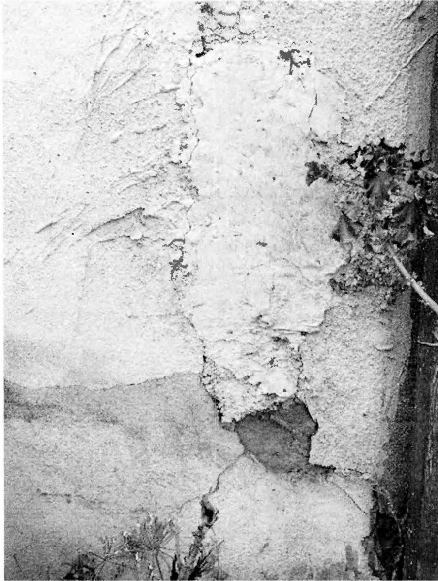
**Figura 18:** Estuco fisurado y soplado en muros de fachada norte.
