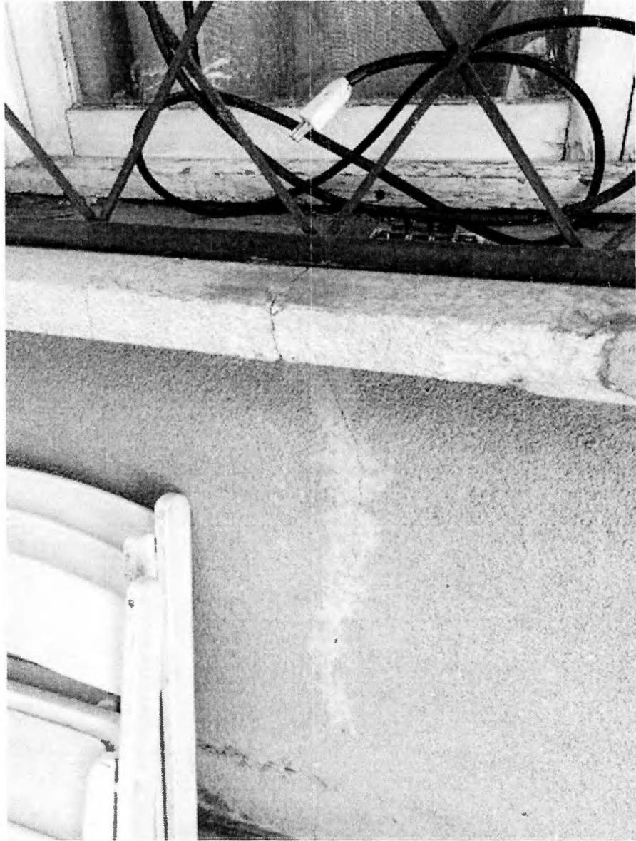
**Figura 22:** Fisura de marquesinas en ventanas, fisura en estuco y elementos metálicos oxidados en fachada este.
