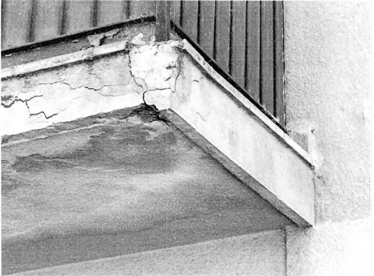
**Figura 29:** Desprendimiento y fisuras en recubrimiento en losa de balcón en fachada oeste.
