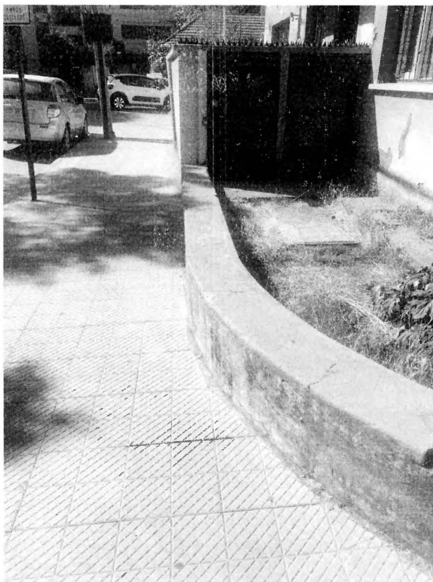
**Figura 36:** Fisura y desprendimiento de hormigón en jardineras de hormigón y nichos de gas a reparar pinturta
