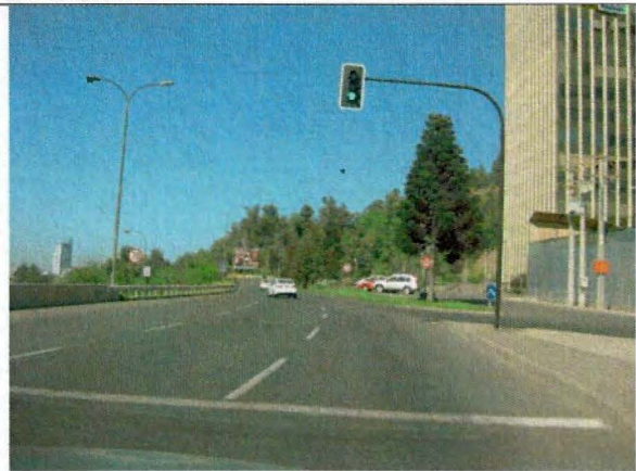
Pavimento sin defectos significativos. Presenta buena nivelación, lisura y compactación del material.
