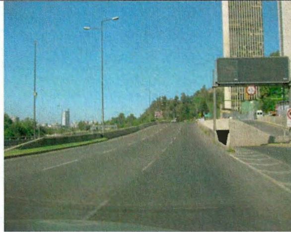
Pavimento en buen estado de conservación al inicio del trecho.
