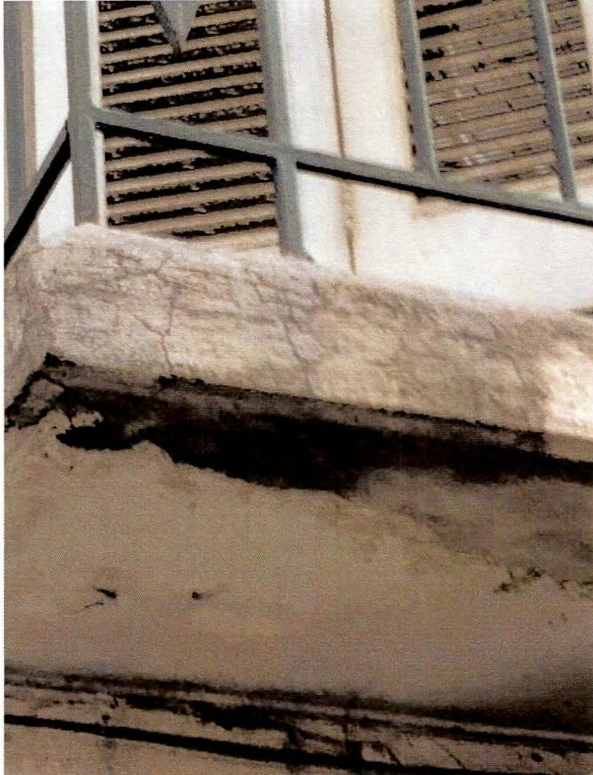
Imagen 6. Sectores con fisura en estucos/recubrimiento en losa de balcones
