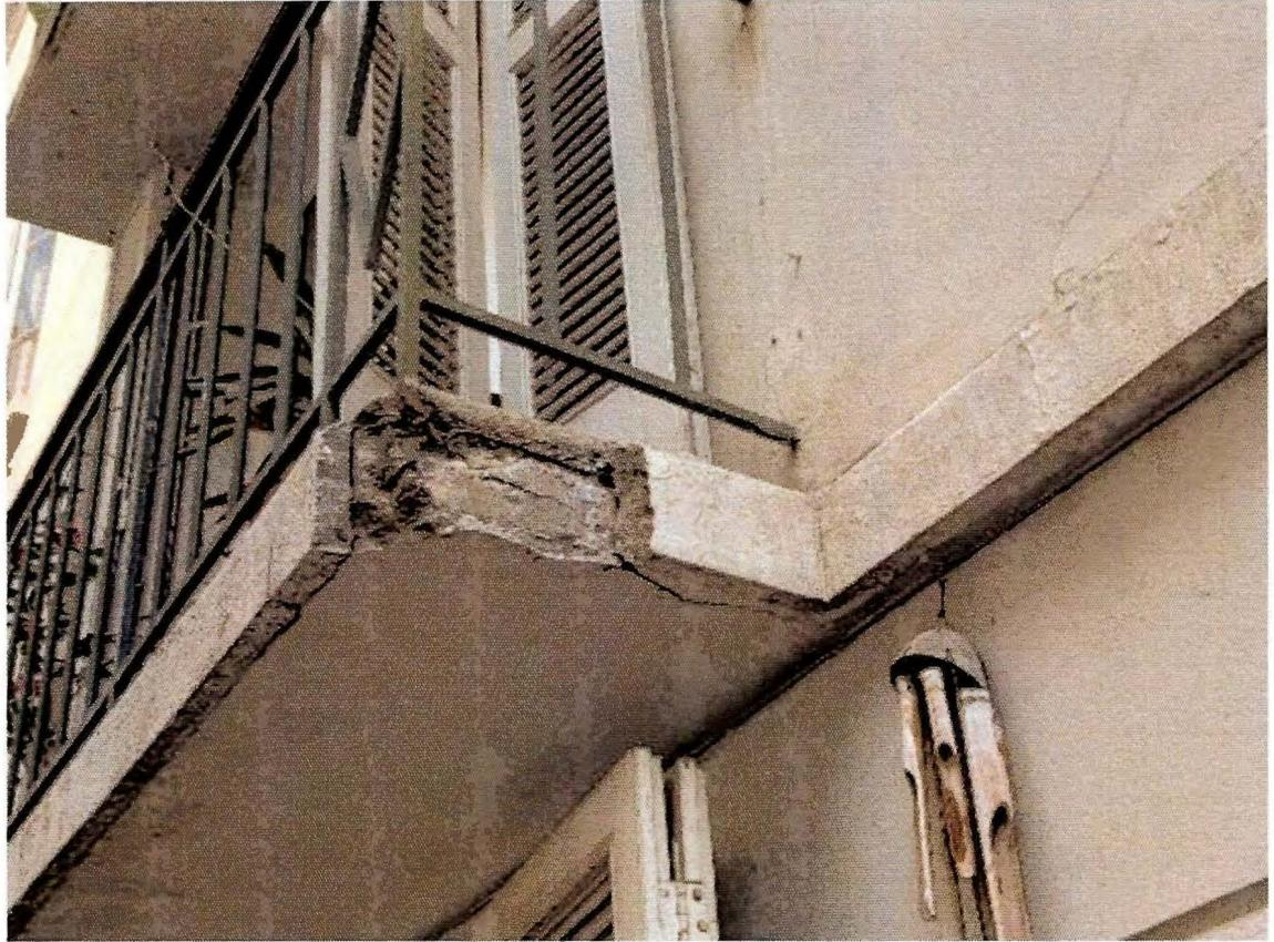
Imagen 5. Daño típico de balcones en estado mas grave de desprendimiento.
