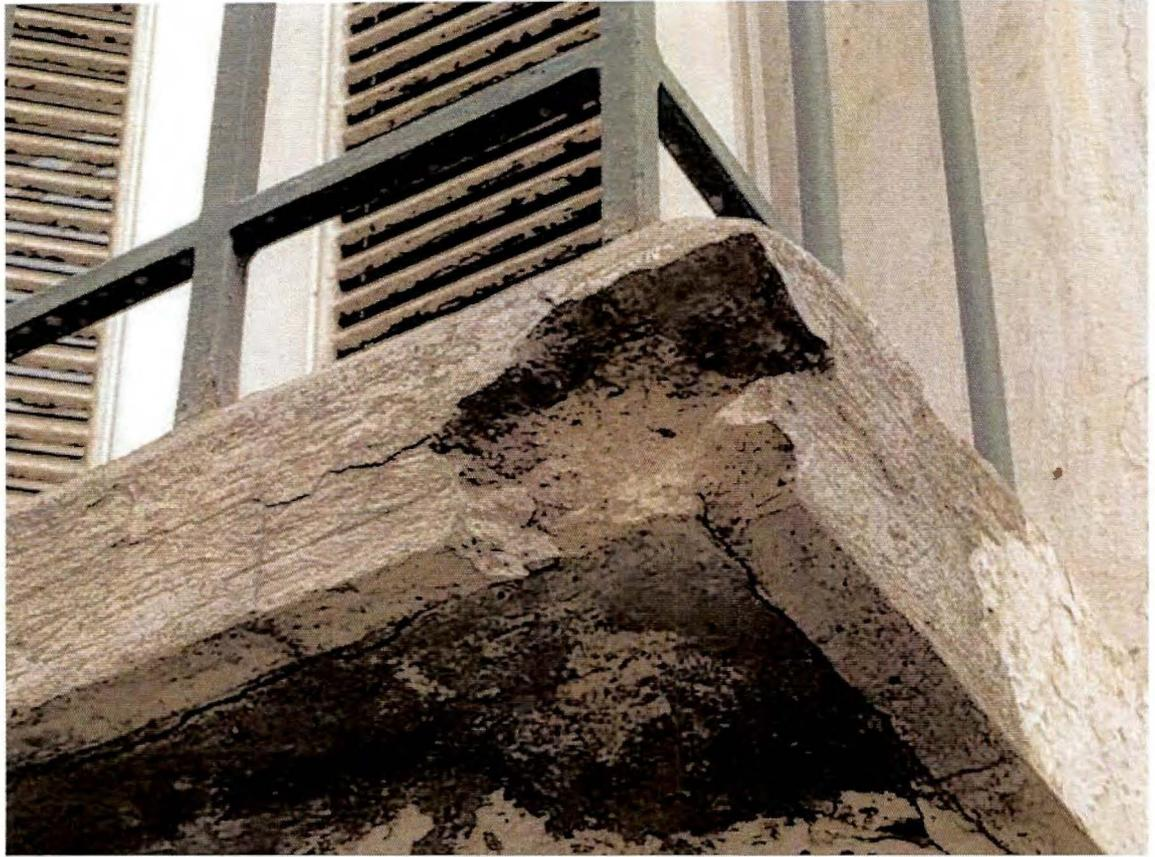
Imagen 7. Sectores con desprendimiento de estucos/recubrimiento en losa de balcones.
