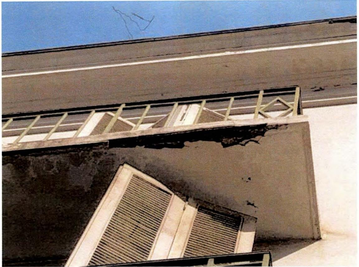
Imagen 8. Desprendimiento inferior de losas y fisuras de cornisa.
