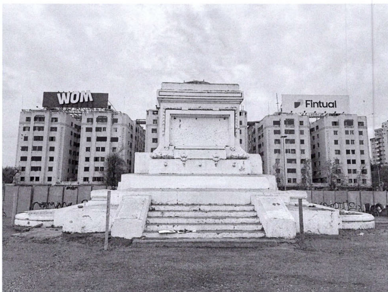
Figura 15: Plinto vacío del Monumento Público al General Baquedano en 2025. Fuente: Municipalidad de Providencia.
