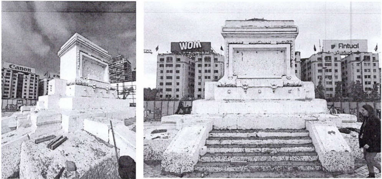
Figura 31: Foto capas pictóricas en la totalidad de la superficie del plinto. Fuente: Municipalidad de Providencia.
