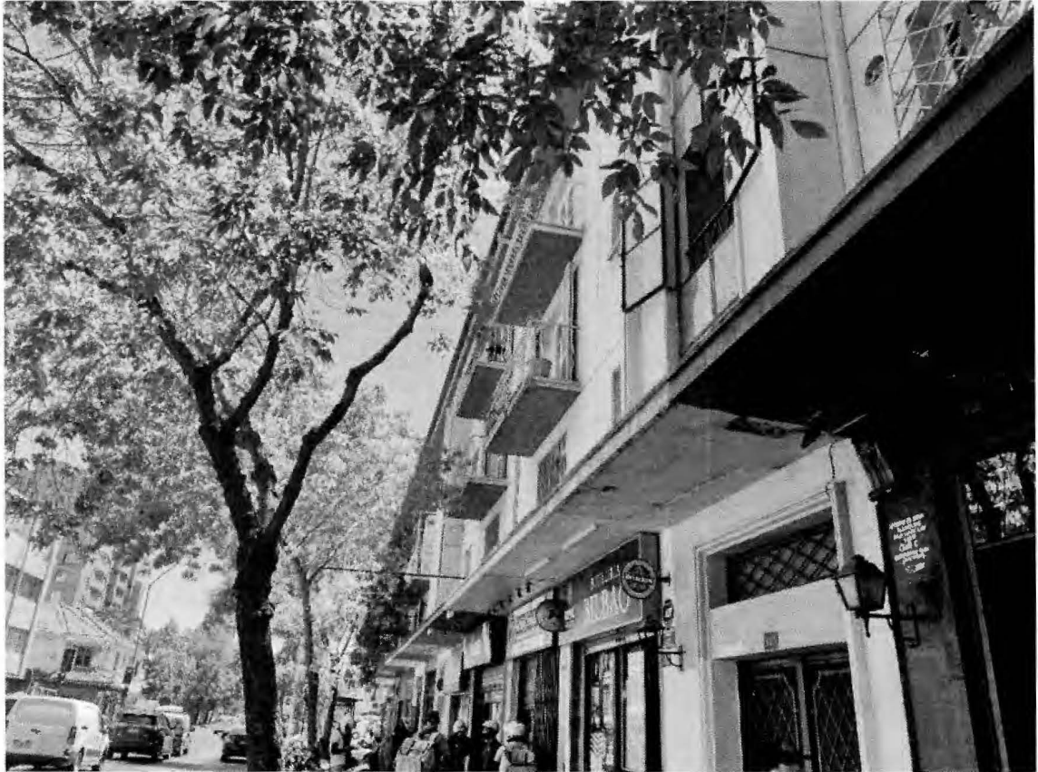
Figura 4: Vista general edificio hacia avenida Francisco Bilbao y locales comerciales en primer piso, fachada sur.
