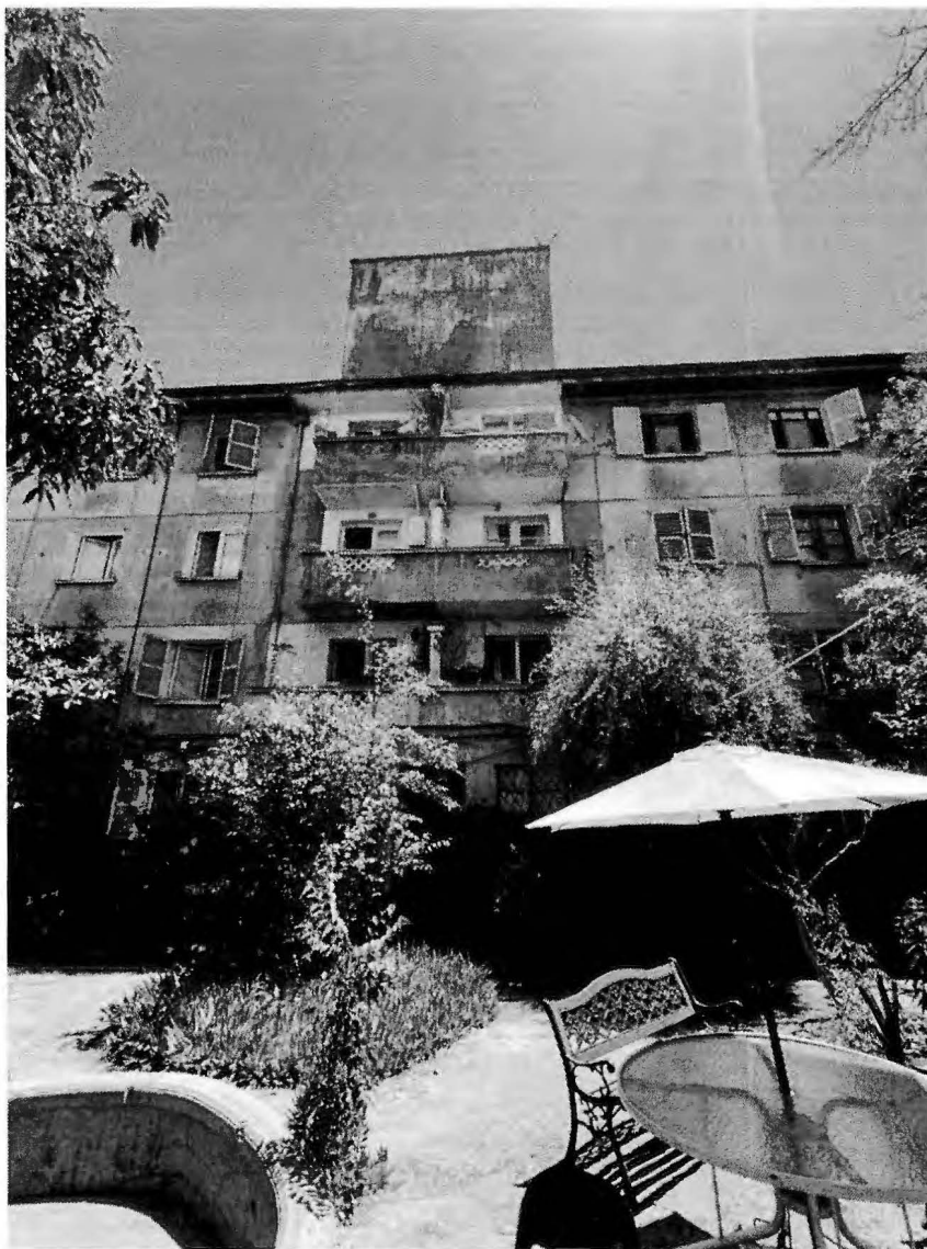
Figura 6: Vista general hacia patio interior, fachada norte. (Alcance del proyecto en esta fachada es sólo reparaciones puntuales)
