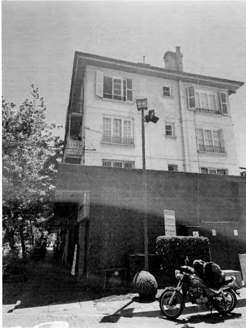
Figura 5: Vista general de edificio hacia centro de venta de combustible en terreno adyacente, fachada este.
