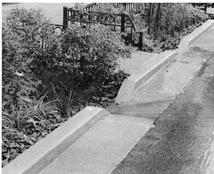
Imagen referencial del rebaje de solera.
