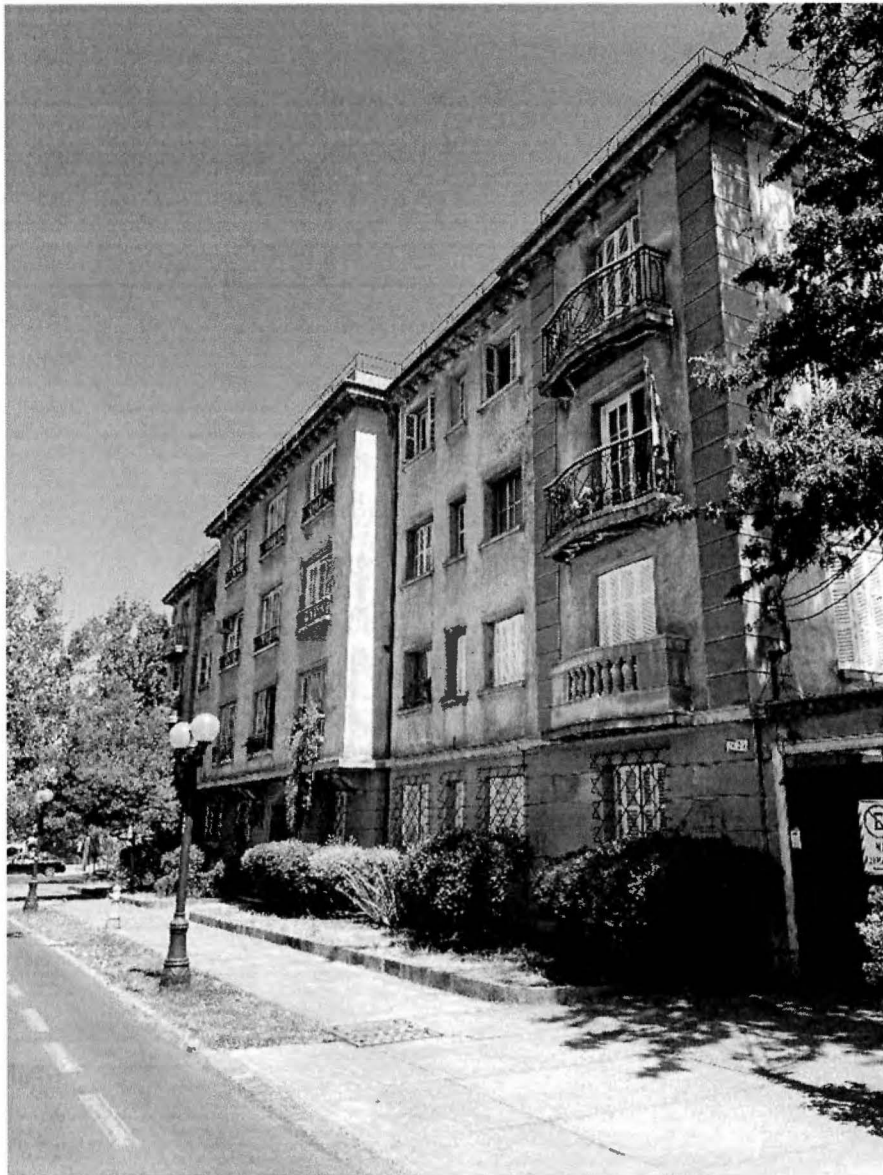
Figura 4: Vista general edificio desde Avenida Pocuro, fachada sur.
