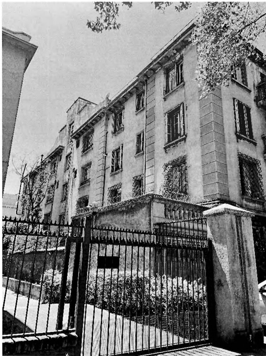
Figura 3: Vista general edificio hacia patio interior, fachada norte.
