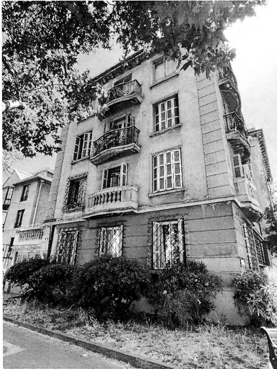
Figura 2: Vista general del edificio hacia Avenida Pedro de Valdivia, fachadas oeste.
