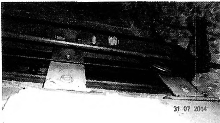
Componentes de apertura de las puertas de piso con exceso de óxido se recomienda su reemplazo.
