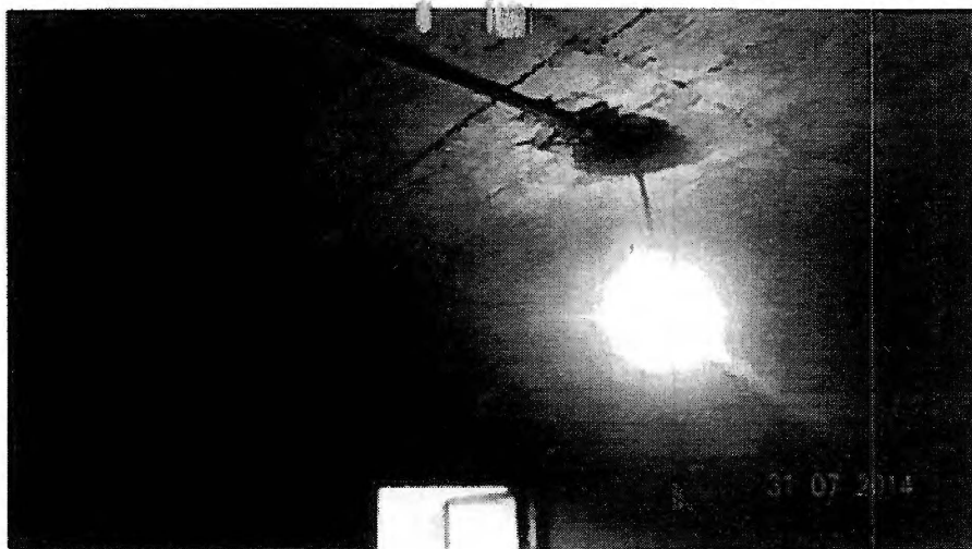
Iluminación de sala de máquinas es deficiente esta debe proporcionar 300lux. Falta instalar iluminación de emergencia sobre la máquina de tracción.
