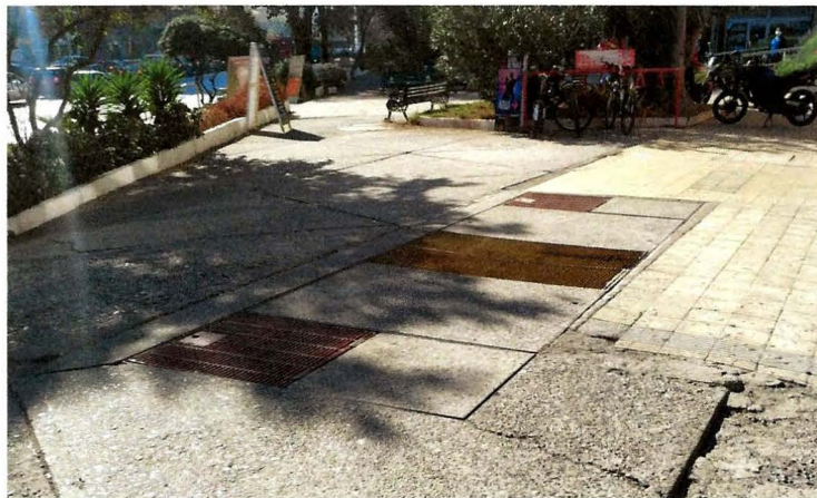
Situación existente subestación eléctrica.
