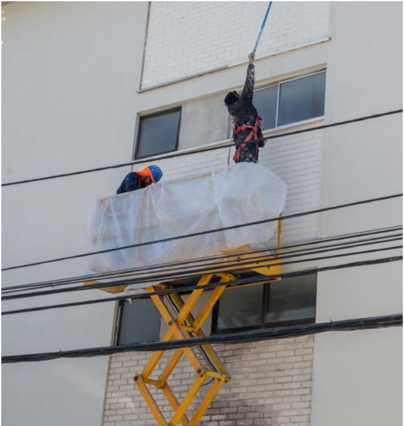
Proyecto Fondevé: Reparación de fachada Comunidad Belo Horizonte.
