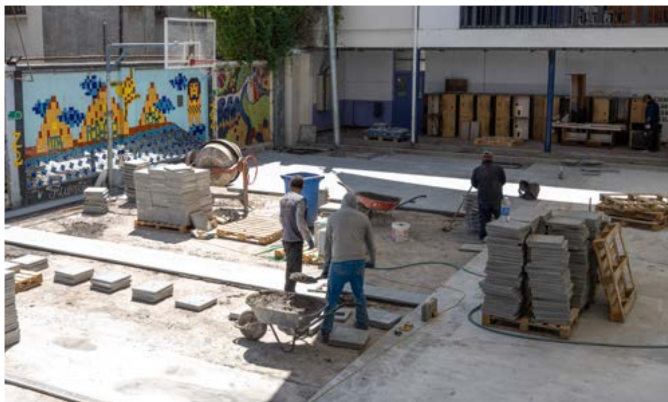
Obras de mejoramiento Liceo Carmela Carvajal.
