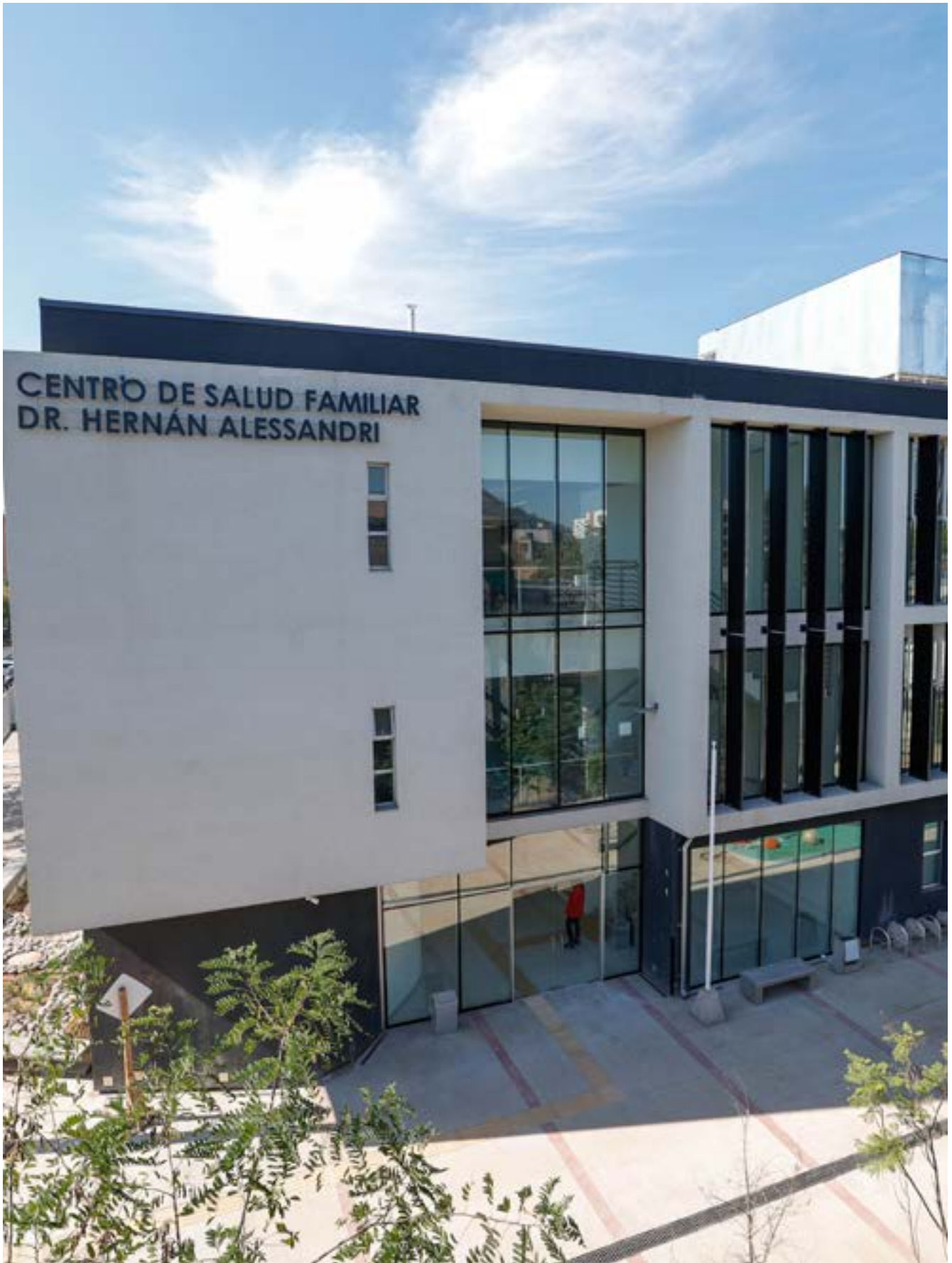
Nuevo Cesfan Dr. Hernán Alessandri, mejorará la atención de salud con moderna infraestructura y equipamiento.
