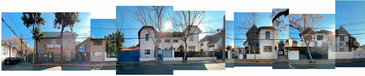
Figura 17 Fotos calle Almirante Zegers Norte. Fuente: Dirección de Barrios y Patrimonio.
