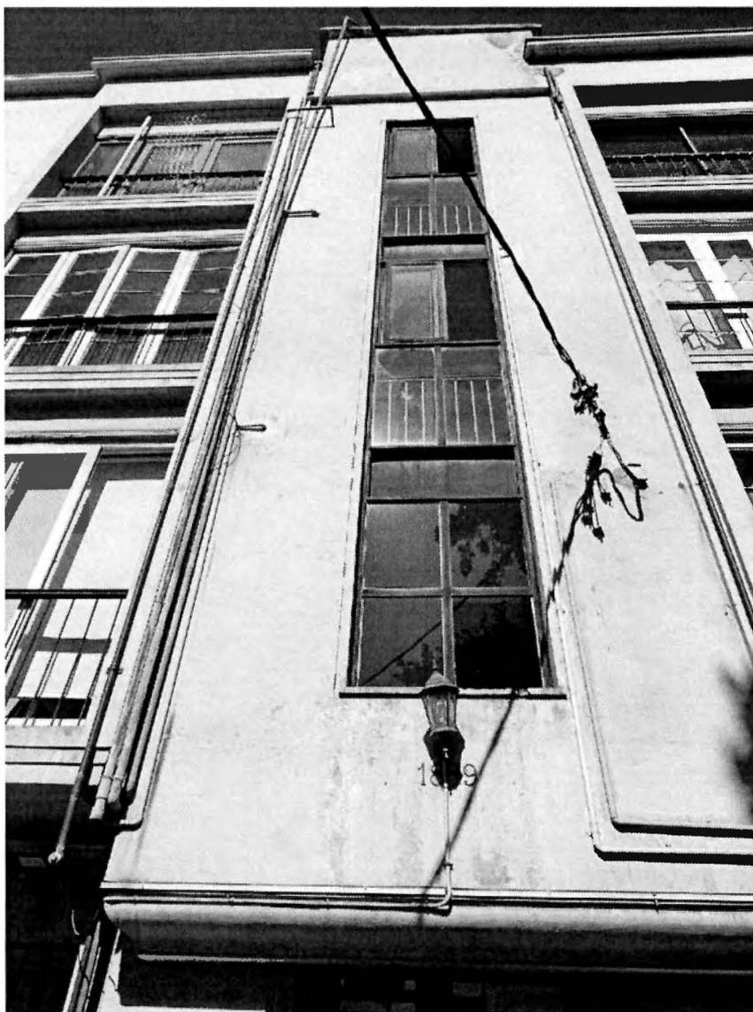
**Figura 27:** Se debe considerar como parte de la limpieza el retiro de tuberías en desuso.
