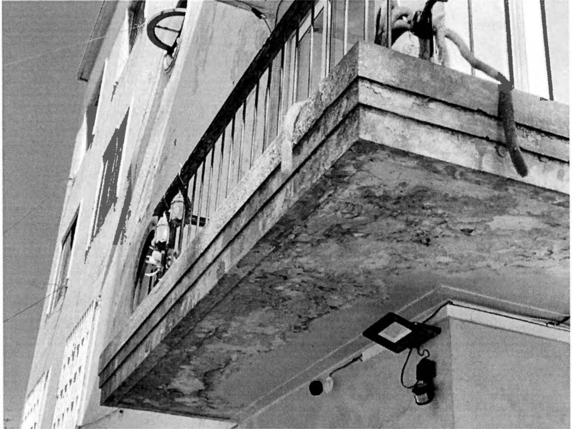
**Figura 23:** Barandas típicas de balcones, las cuales se deben modificar, aumentando su altura y cambio de pasamanos. Altura actual 80 cm, se deben instalar suplemento para dejar en 120 cm de altura. Además, se debe considerar mejorar el anclaje.
