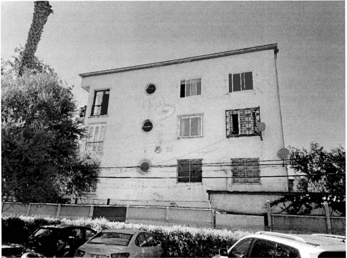
**Figura 17:** Vista general de desprendimientos de pintura por humedad en fachada norte.
