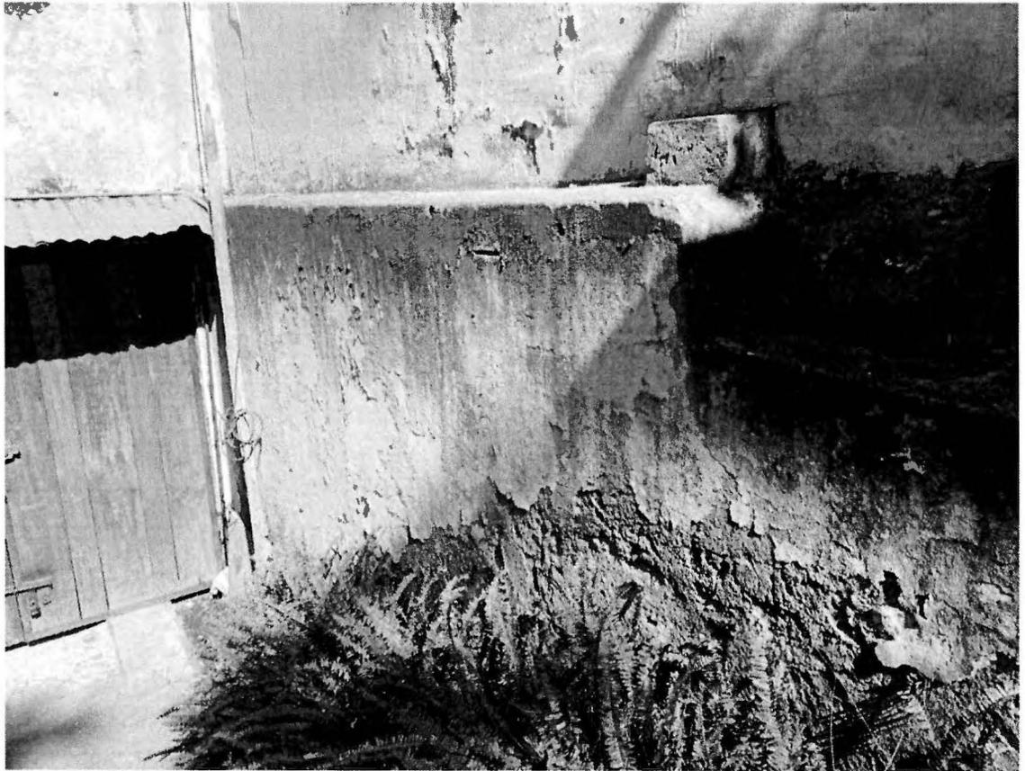
**Figura 19:** Fisuramiento y desprendimiento de estucos en sector inferior de muros de fachada sur.
