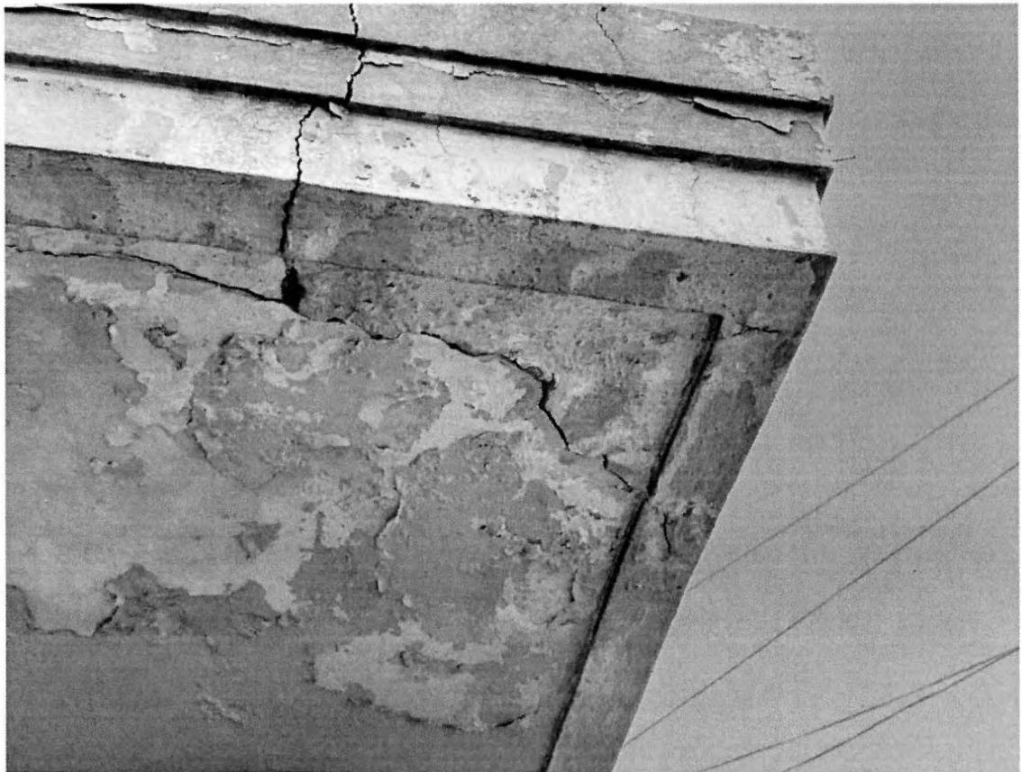
**Figura 11:** Fisuramiento típico en recubrimiento de losas de balcones de fachada oriente.
