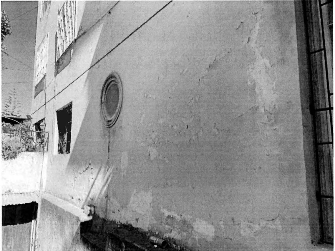
**Figura 13:** Daño por humedad en pinturas de fachada sur, hacia calle Bustos
