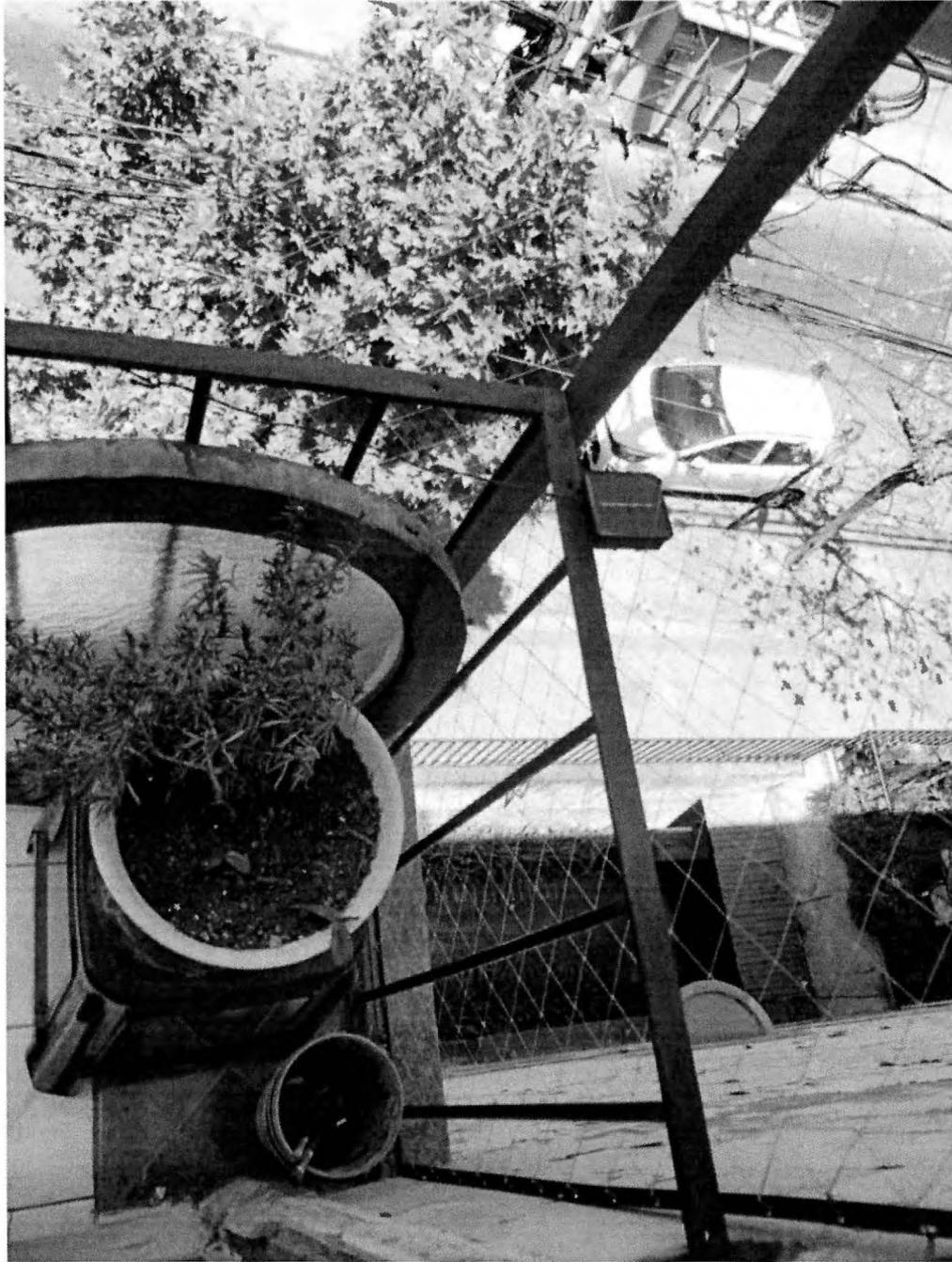
**Figura 25:** Reparar y/o mejorar anclaje de baranda en muros.
