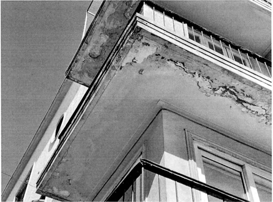
**Figura 12:** Pinturas sueltas bajo losa de balcones, dañados por humedad.
