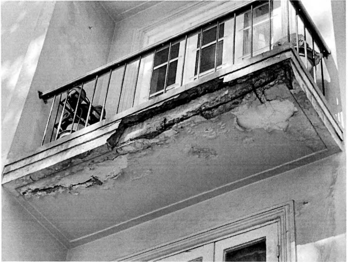
**Figura 10:** Daño por desprendimiento en losa de balcones, fachada oriente.
