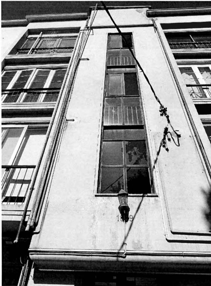
**Figura 7:** Daño por humedad en fachada oriente, ventanas metálicas con oxido y deterioro en pintura.
