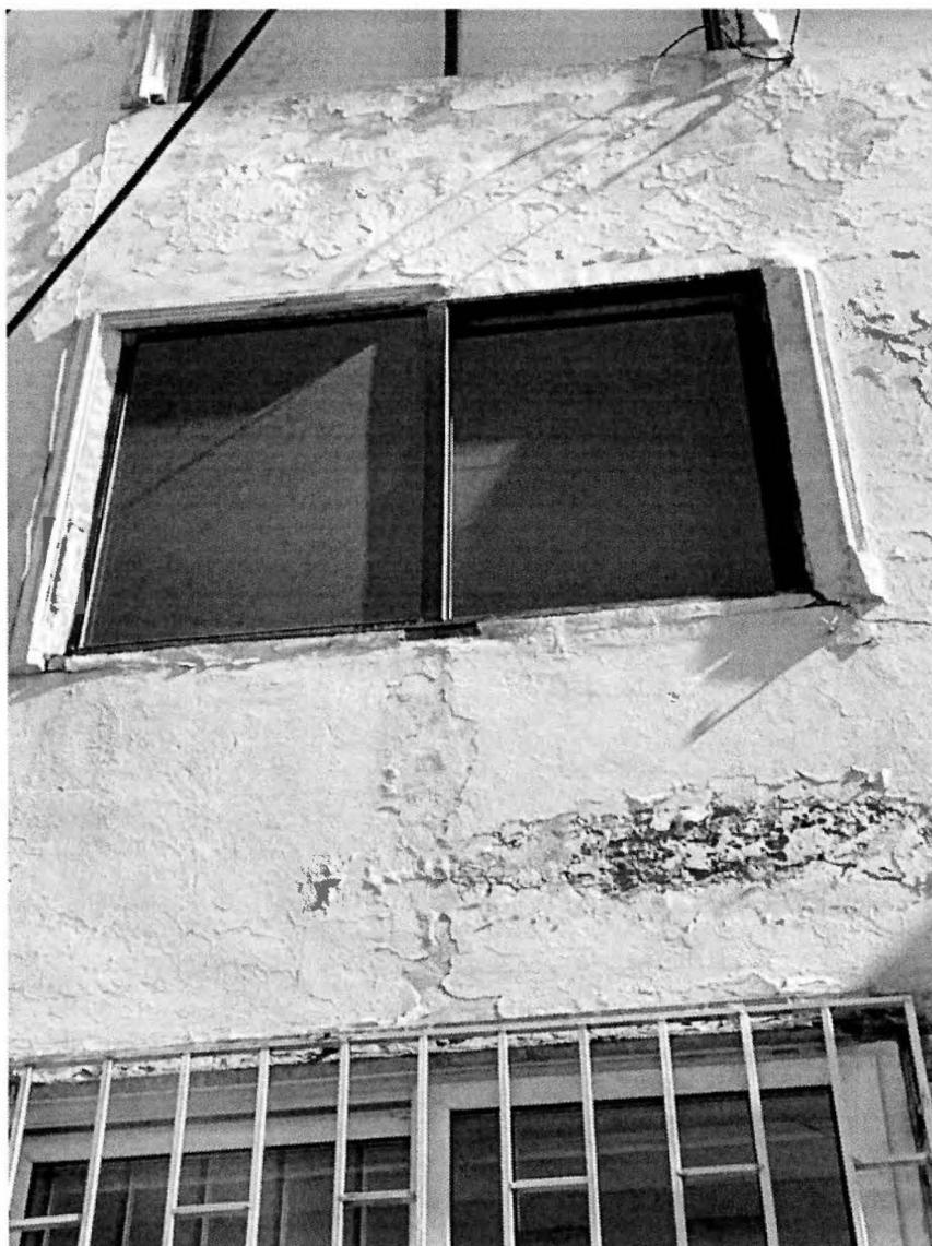
**Figura 26:** Desprendimiento de molduras o pilastras de ventanas y protecciones de ventanas a limpiar y volver a pintar.
