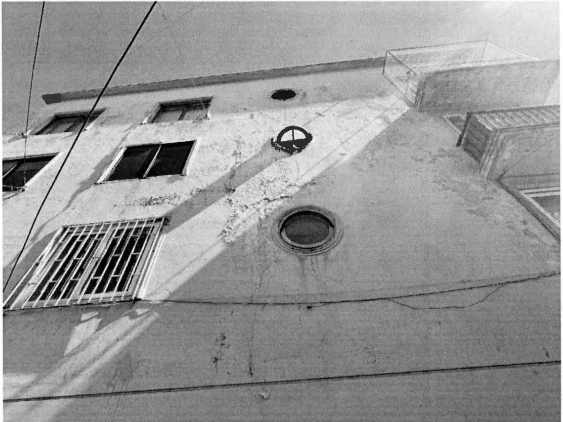
**Figura 15:** Vista general de desprendimiento moldura de hormigón en contornos de ventanas, y daños por humedad en muros de fachada sur.
