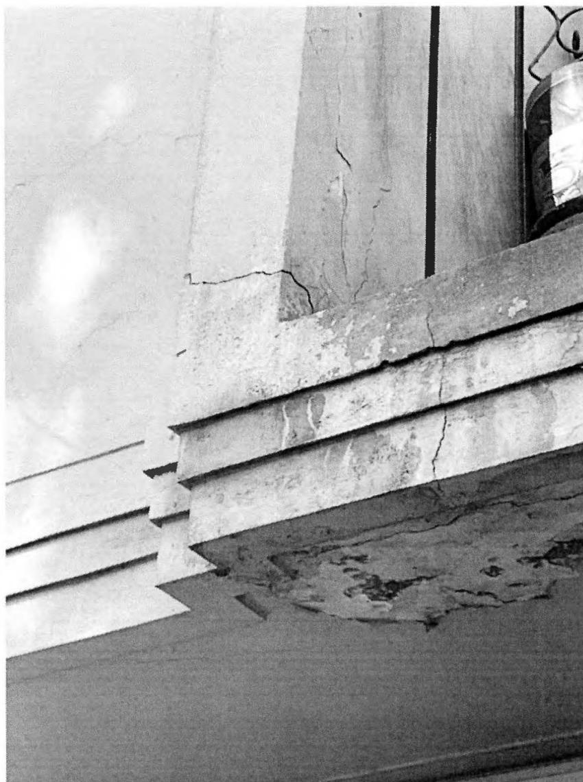
**Figura 8:** Fisura en losa de balcones y daños por humedad en sector inferior de losa de balcones.
