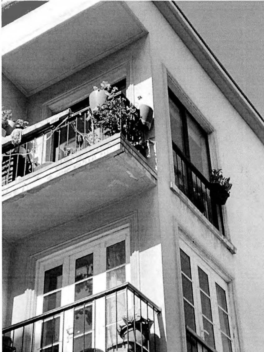
**Figura 6:** Daño típico desprendimiento en losa de balcones, de fachada oriente
