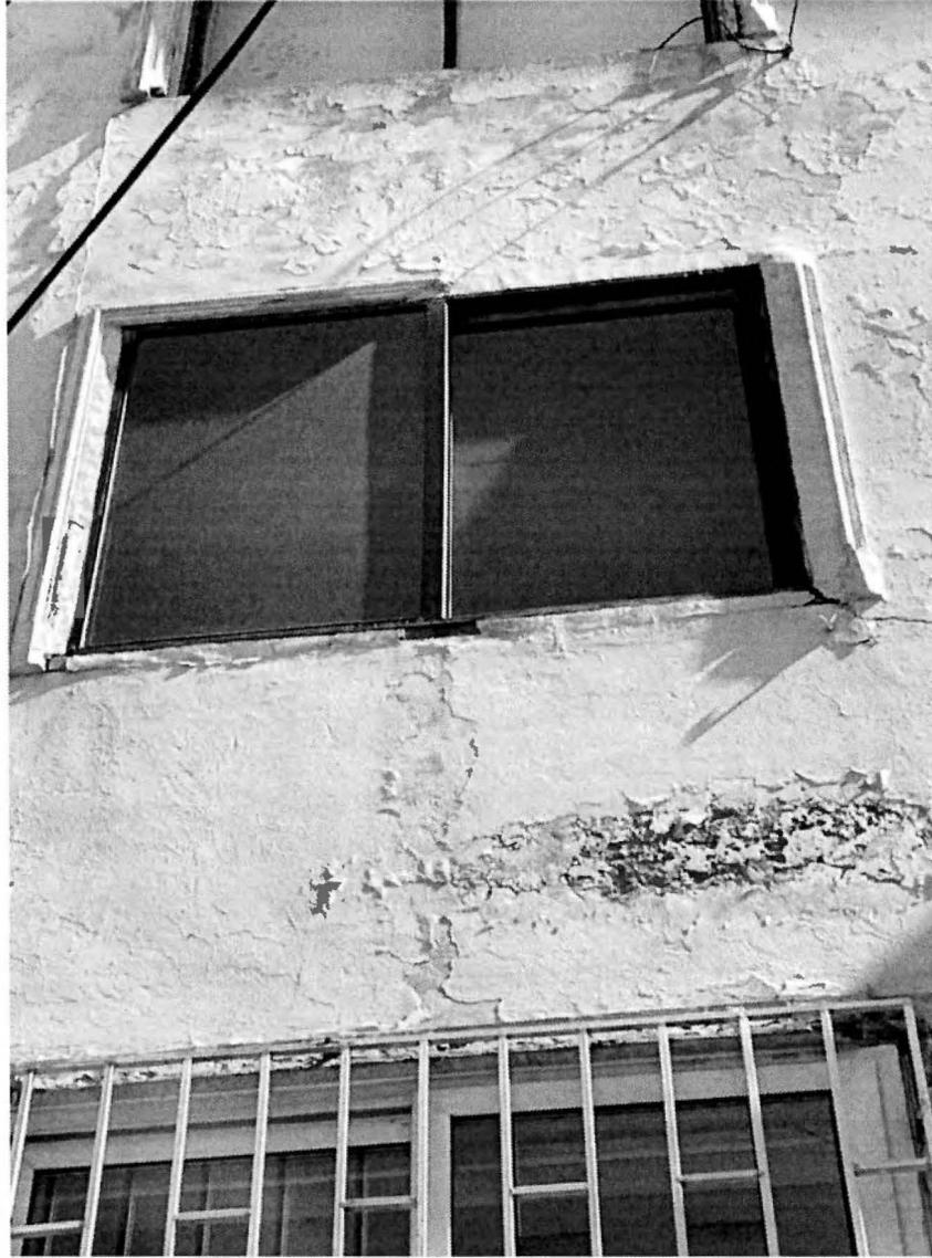
**Figura 14:** Desprendimiento moldura de hormigón en contornos de ventanas, y daños por humedad en muros. Fachada sur.
