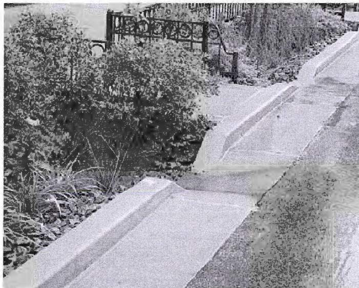
Imagen referencial del rebaje de solera.
