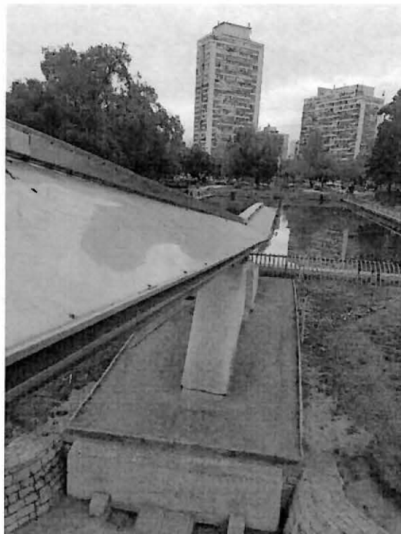
Figura 2: Vista apoyo de monumento en base central.
