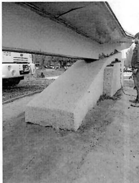
Figura 12: Unión de estructura metálica y base.
