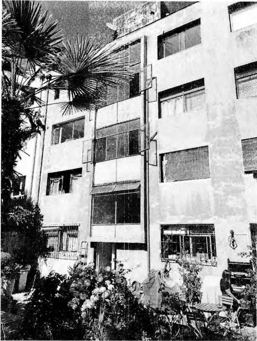
Figura 3: Vista general edificio hacia patio interior, fachada este.
