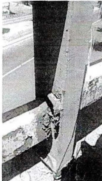
Ilustración 4: Deterioro por Oxido en Conexión
