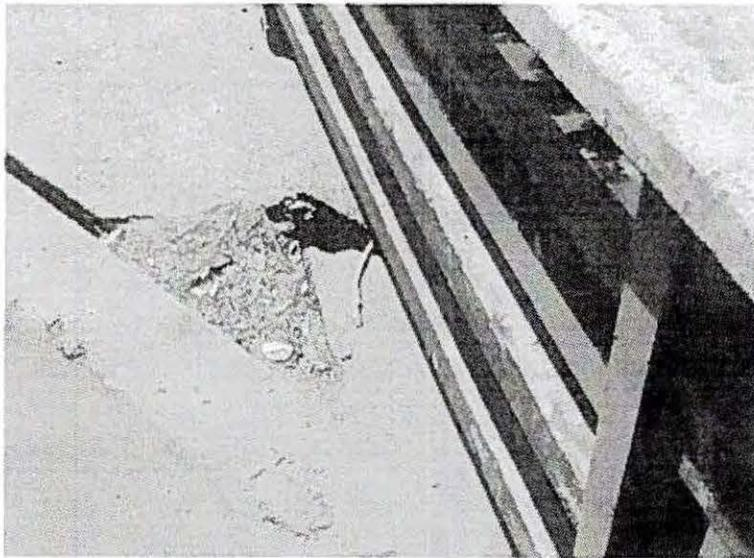
Ilustración 6: Rotura en Junta de Dilatación
