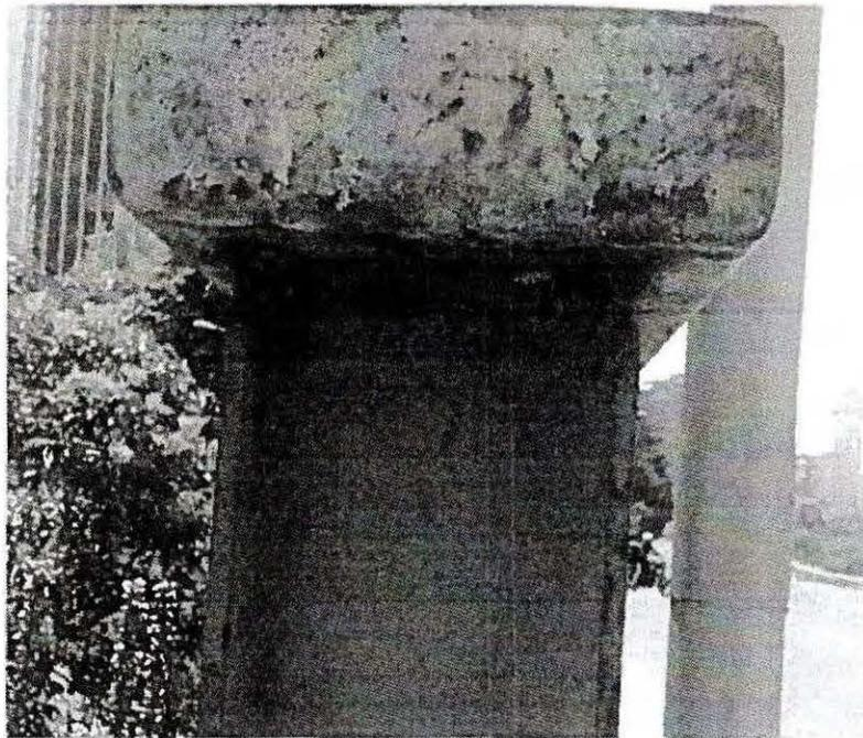
Ilustración 3. Deterioro por Oxido
