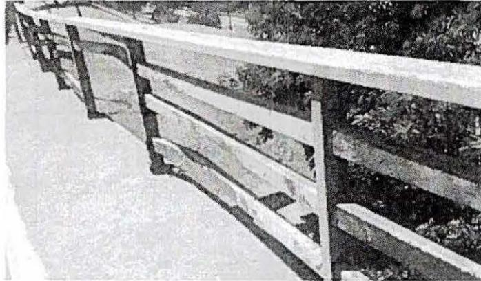
Ilustración 5: Perda de elementos laterales por impactos de vehículos
