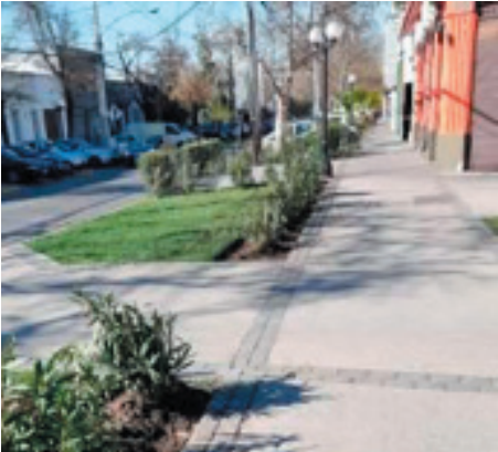
Pavimentos de baldosa de huevillos (izquierda) y hormigón con adoquines (derecha)
