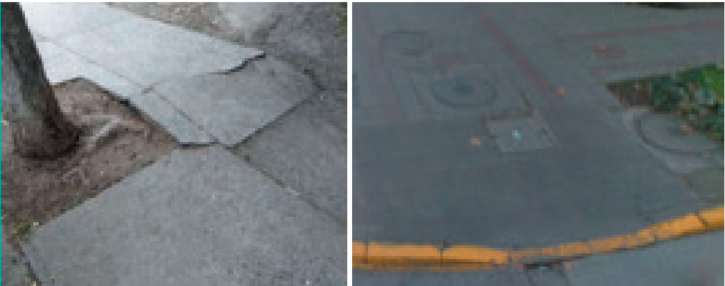
Pavimentos de baldosa de huevillos (izquierda) y hormigón con adoquines (derecha)
