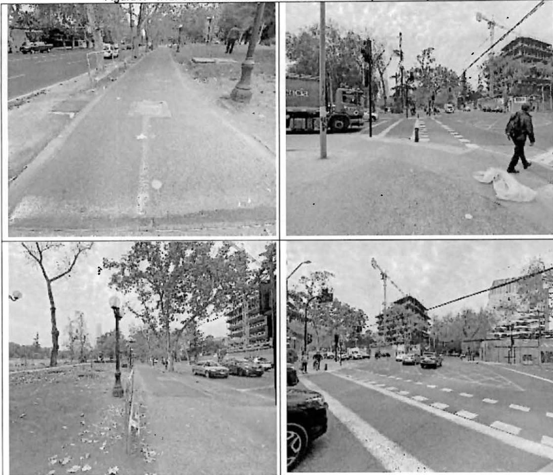
Observaciones: Como se puede apreciar en las imágenes, la ciclovía de Av. Andrés Bello corresponde a una ciclovía Bidireccional con dirección Oriente – Poniente y viceversa, la ciclovía se encuentra en buenas condiciones, sin embargo se encuentra con la demarcación desgastada, posee elementos de seguridad según lo requerido.
