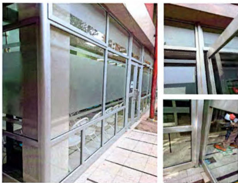
Figura 29. Línea de diseño, Tabiques vidriados existentes (zona sala de espera acceso norte)
