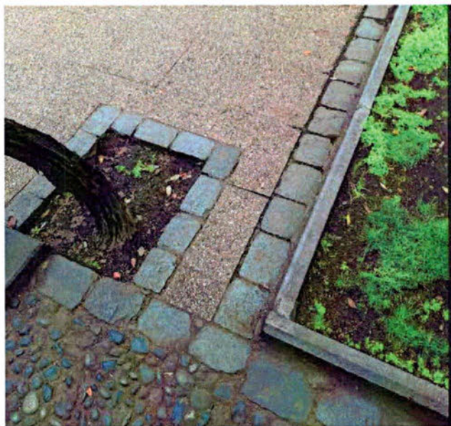
Figura 6. Adoquines existentes en zona norte de intervención.
