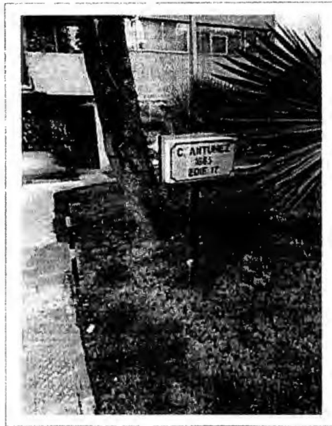
Figura N°1, Edificio Carlos Antúnez 1865
