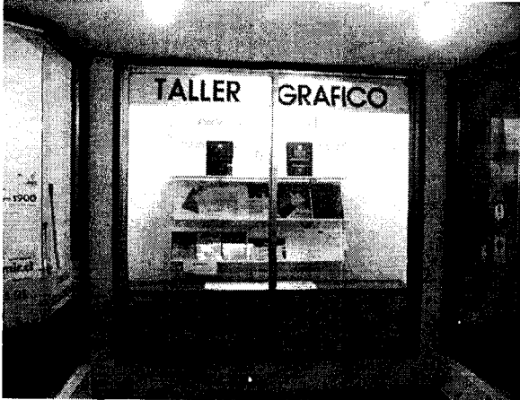
Imagen 11: Mostrador local N°30 donde se observa presencia de humedad.
