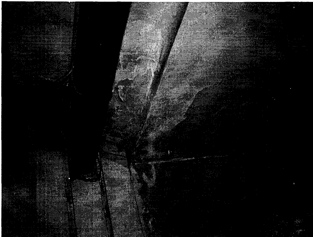
Imagen 6: Presencia permanente de humedad.
