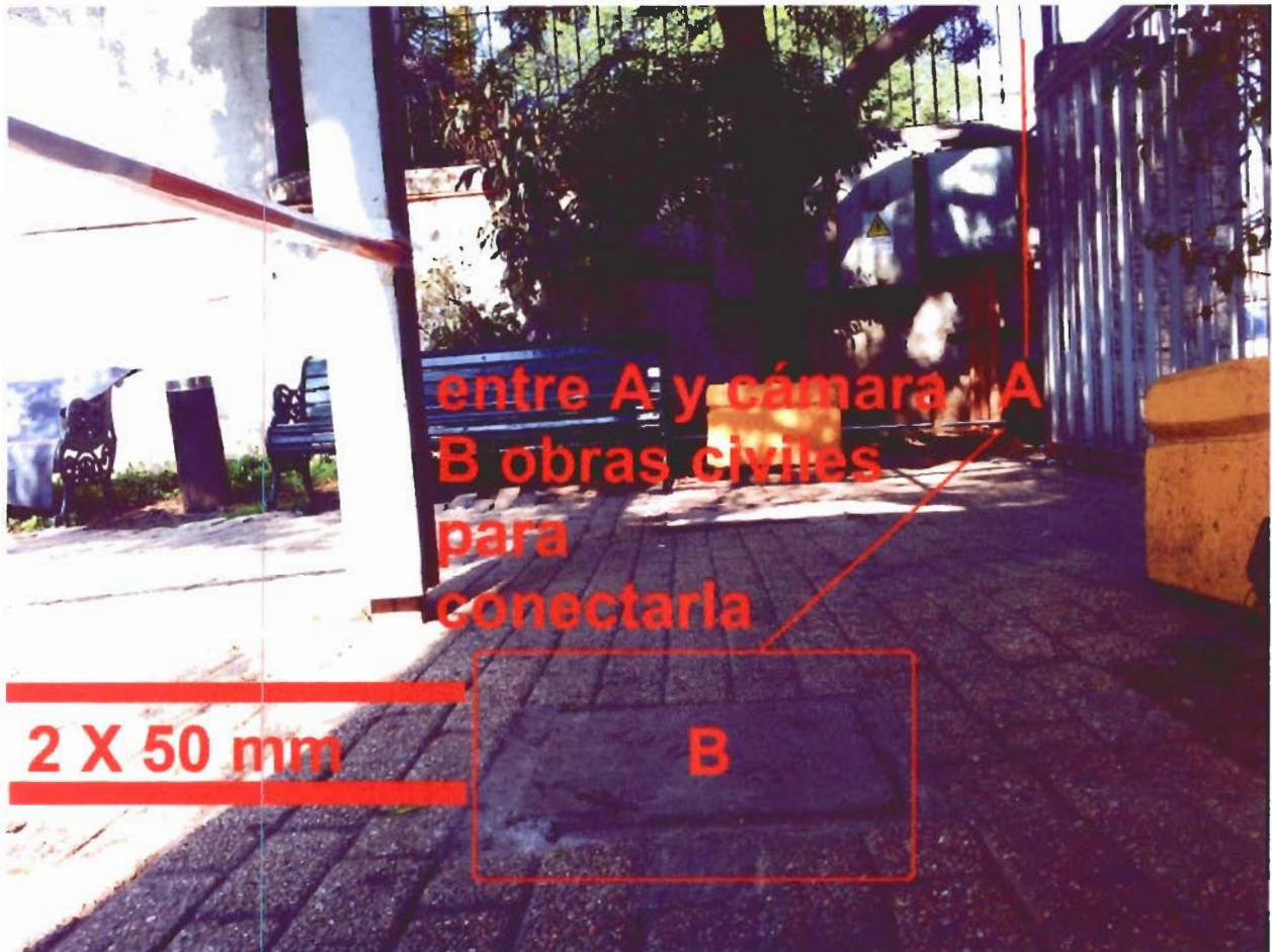
Cámara B y ductos salientes desde esta existentes.
