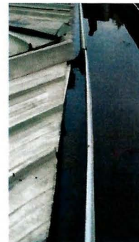
Canaletas con aguas lluvias no evacuadas y jardinera con aguas lluvias estanca
