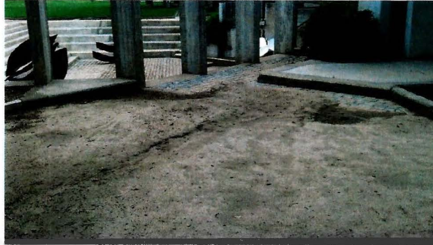
El nivel de terreno a nivel del edificio, en terreno sentido de escurrimiento de las aguas lluvias
