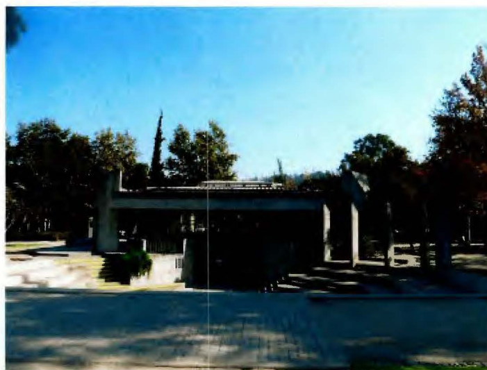
Vista sur de la Sala de Exposiciones
