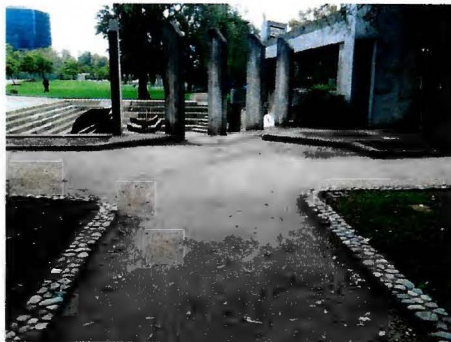
Desde pasillo peatonal y jardines baja aguas lluvias al edificio
