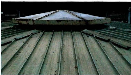
Vista parcial cubierta
