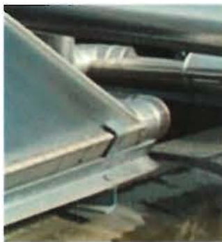
Figura 2. Perfiles de la estructura metálica dispuestos de forma en la que no acumulan agua.
