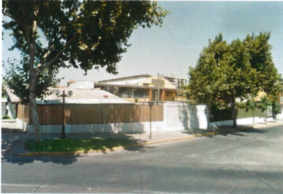
Figura 2. Vista del edificio de la DAOM desde calle Santa Isabel.
