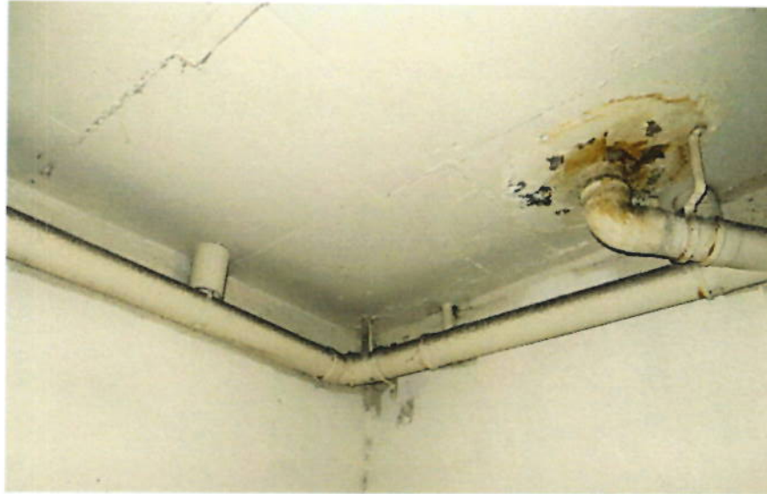
Primer subterráneo - bajo acceso edificio
