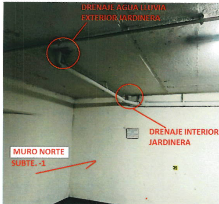
Primer subterráneo - muro norte
