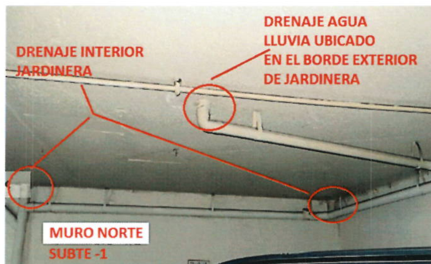
Primer subterráneo - muro norte
