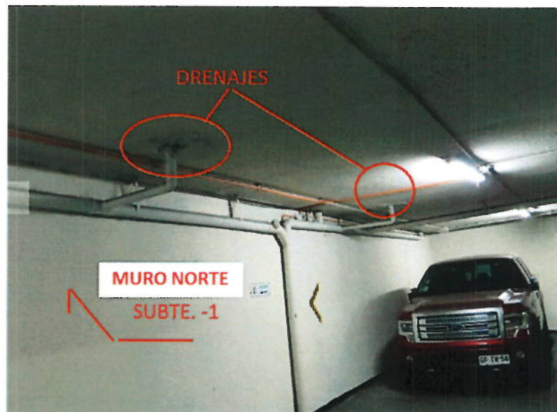
Primer subterráneo - muro norte
