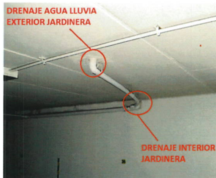
Primer subterráneo - muro norte
