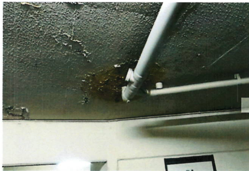
Primer subterráneo - bajo acceso edificio
